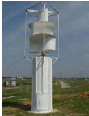
Şekil 4.2. Düşey eksenli düz tip bir darrieus rüzgar türbini
