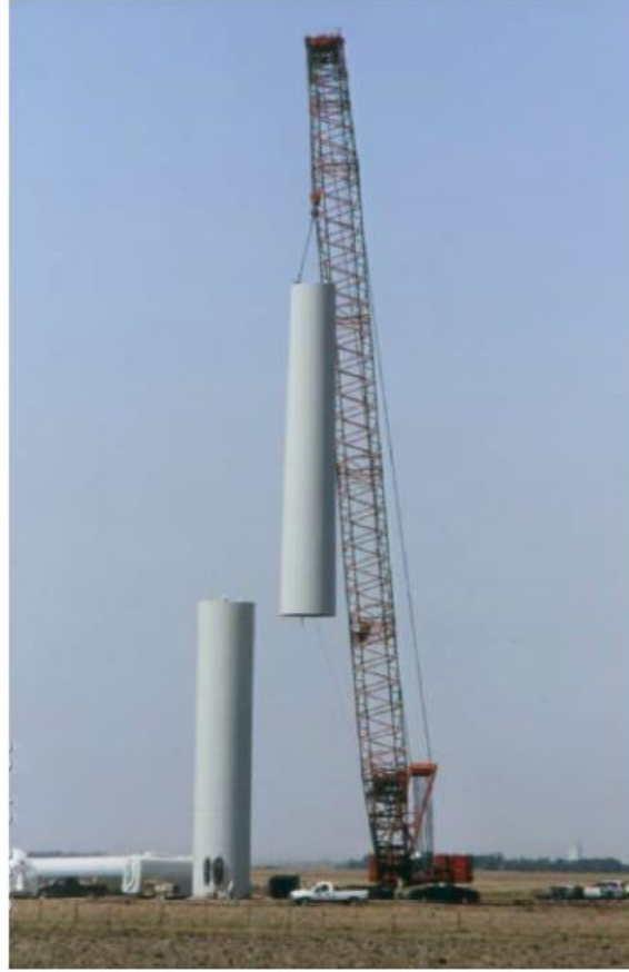
Şekil 6.3 : Çelik kule montajı.
