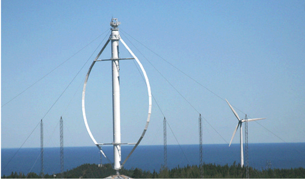
Şekil 2.3 : Dikey eksenli bir rüzgar türbini.
