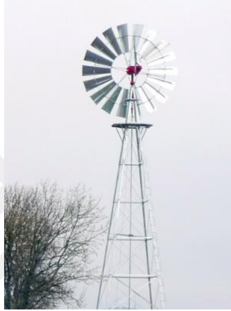
Şekil 1.5. Çok Kanatlı Rüzgar Türbini
