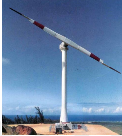
Şekil 1.3. Çift Kanatlı Rüzgar Türbini
