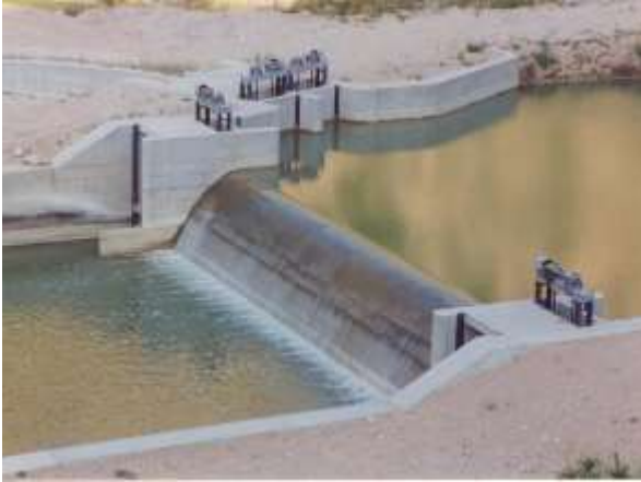
Şekil 2.3 (c). Denizli-Baklan Ovası Sulamasına ait Erenler Regülatörü (dolu gövdeli, mansaptan ve membadan görünüş) (Gürsoy, 2010)
