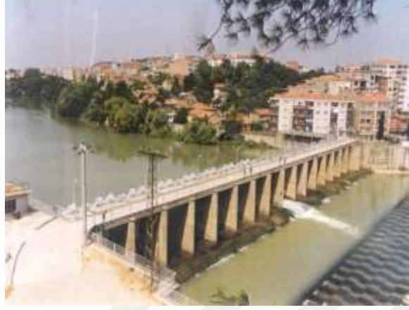
Şekil 2.4. Mustafa Kemal Paşa Regülâtörü (kapaklı regülâtör - mansaptan görünüş) (Gürsoy, 2010)
