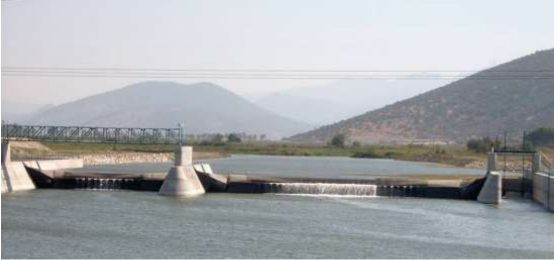
Şekil 2.9. Aşağı Büyük Menderes Nehri üzerindeki lastik savaklı regülatör (işletme halinde) (Gürsoy, 2010)
