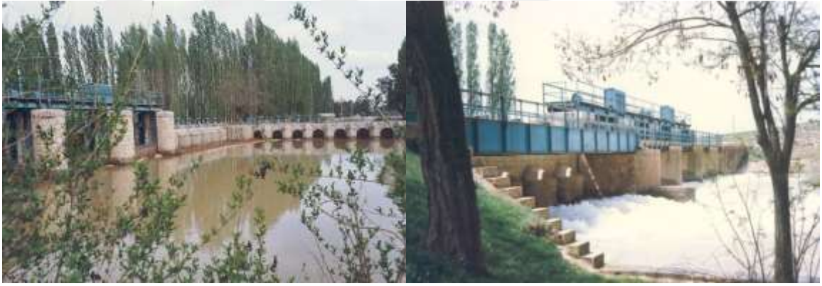
Şekil 2.5. Konya - Çumra Kısıkyayla Regülâtörü - 1913 (kapaklı regülâtör) (mansaptan ve membadan görünüş) (Gürsoy, 2010)
