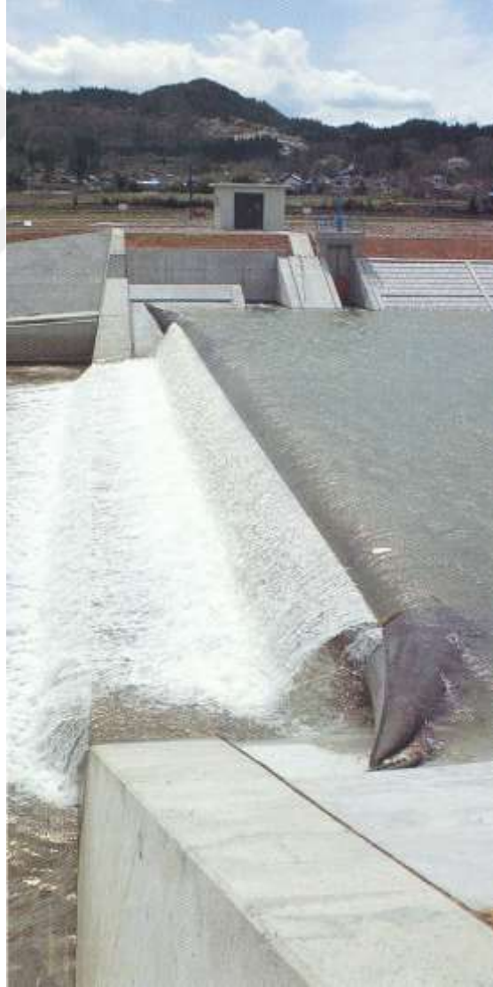
Şekil 2.8. Lastik savaklı regülatör (mansaptan görünüş) (Gürsoy, 2010)
