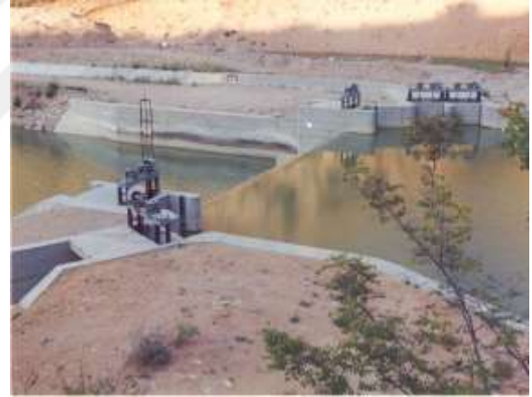
Şekil 2.3 (c). Denizli-Baklan Ovası Sulamasına ait Erenler Regülatörü (dolu gövdeli, mansaptan ve membadan görünüş) (Gürsoy, 2010)
