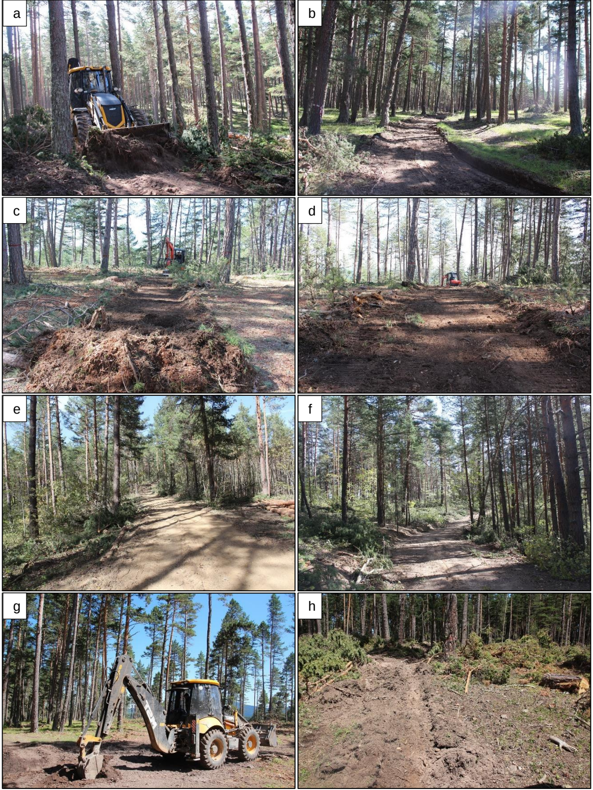
Şekil 12. Yangın parsellerinin çevresine güvenlik şeridinin açılması (a, b, c ve d), mevcut yolların temizlenerek bakımlarının yapılması (e ve f) ve parsel sınırlarının işaretlenmesi (g ve h)
