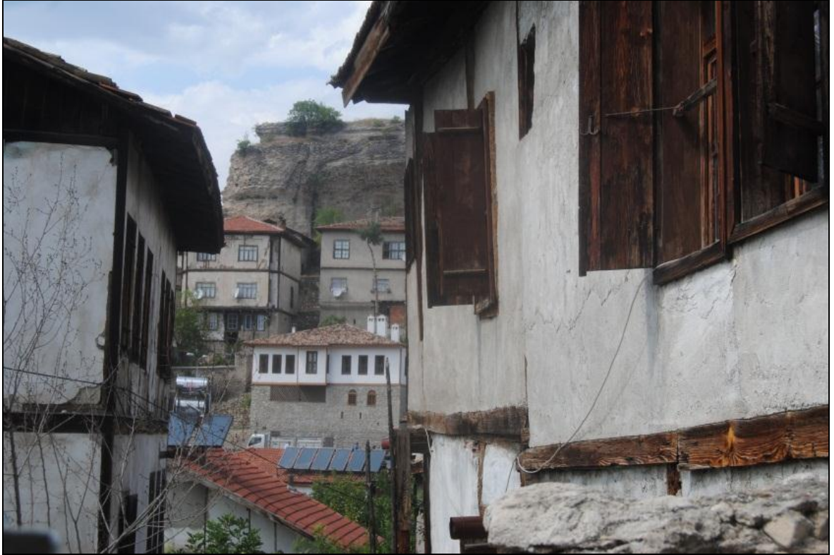
Şekil 31: Safranbolu geleneksel yerleşimindeki yapı malzemeleri ve güneş kollektörleri (Orijinal, 2014).
