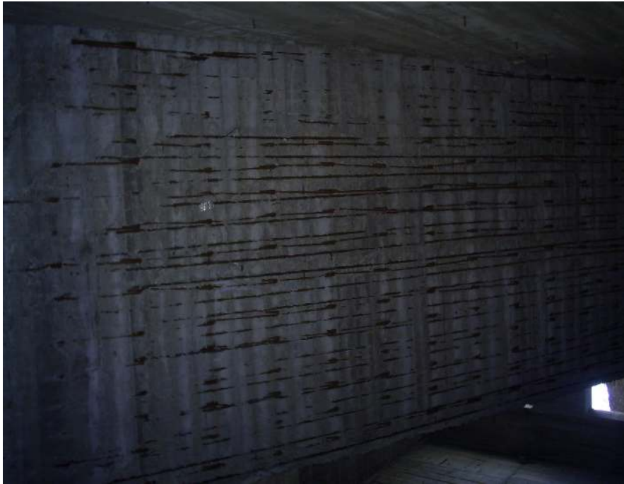
Fotoğraf 4.6. Kötü Kalıp İşçiliği ve Açığa Çıkan Donatılar-2
