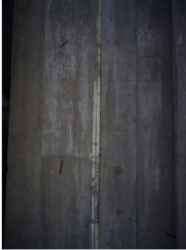
Fotoğraf 4.4. P2-O Bloğu'nda Uygulanmakta Olan Dilatasyon Derzi
