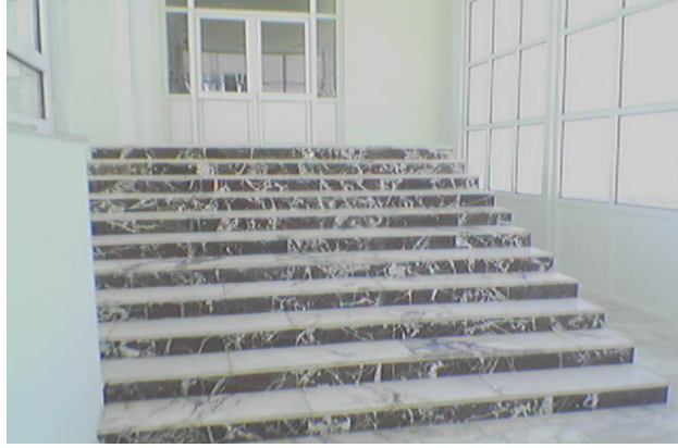
Fotoğraf 4.20. Kol Genişliği Duvar Tarafından Kesilen Merdiven
