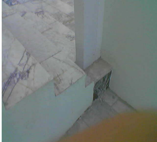
Fotoğraf 4.20. Kol Genişliği Duvar Tarafından Kesilen Merdiven
