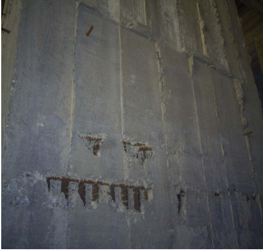
Fotoğraf 4.5. Kötü Kalıp İşçiliği ve Açığa Çıkan Donatılar
