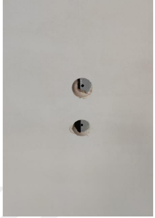
Şekil 4.11. Aydınlatma spotu ile asma tavan taşıyıcı karkasın çıkışması
