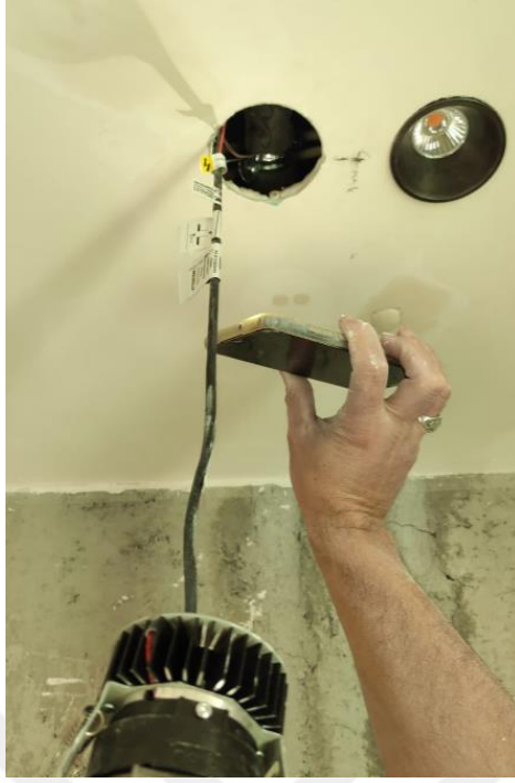
Şekil 4.10. Aydınlatma spotu ile mekanik tesisat çıkışması
