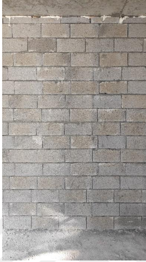
Şekil 4.4. Duvar uygulama projesi doğrultusunda yapılan imalat
