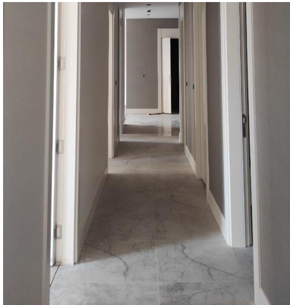
Şekil 3.1. 60x60cm seramik boyutuna göre ayarlanmış koridor
