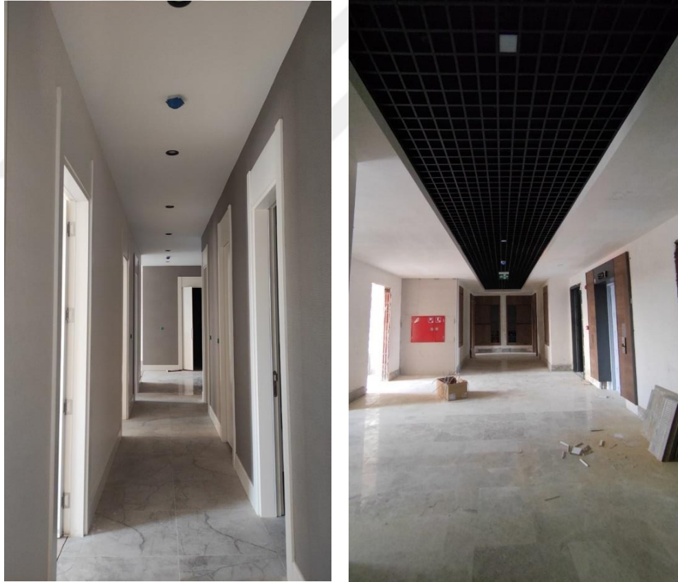
Şekil 4.13. Asma tavan uygulama projesi doğrultusunda yapılan tavan imalatları
