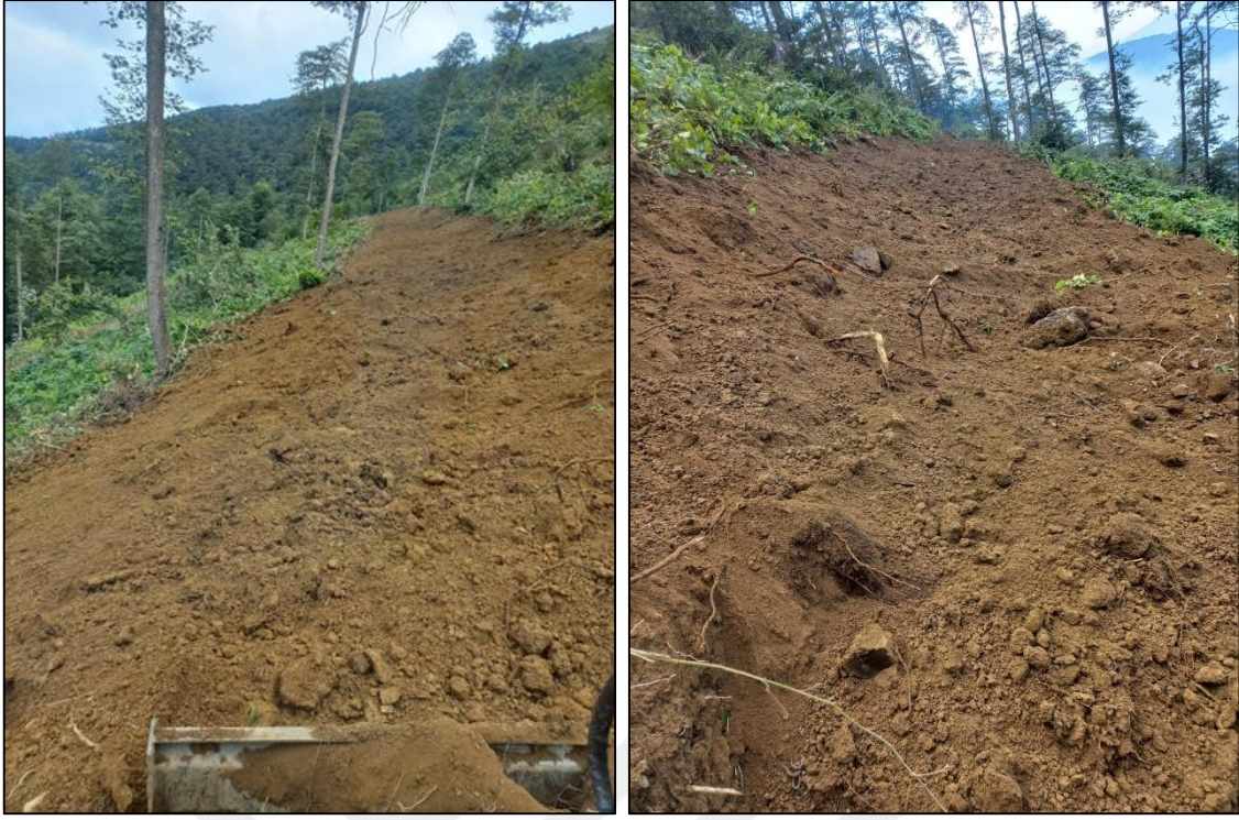
Şekil 2. 6 Saha hazırlığının gerçekleştirilmesi
