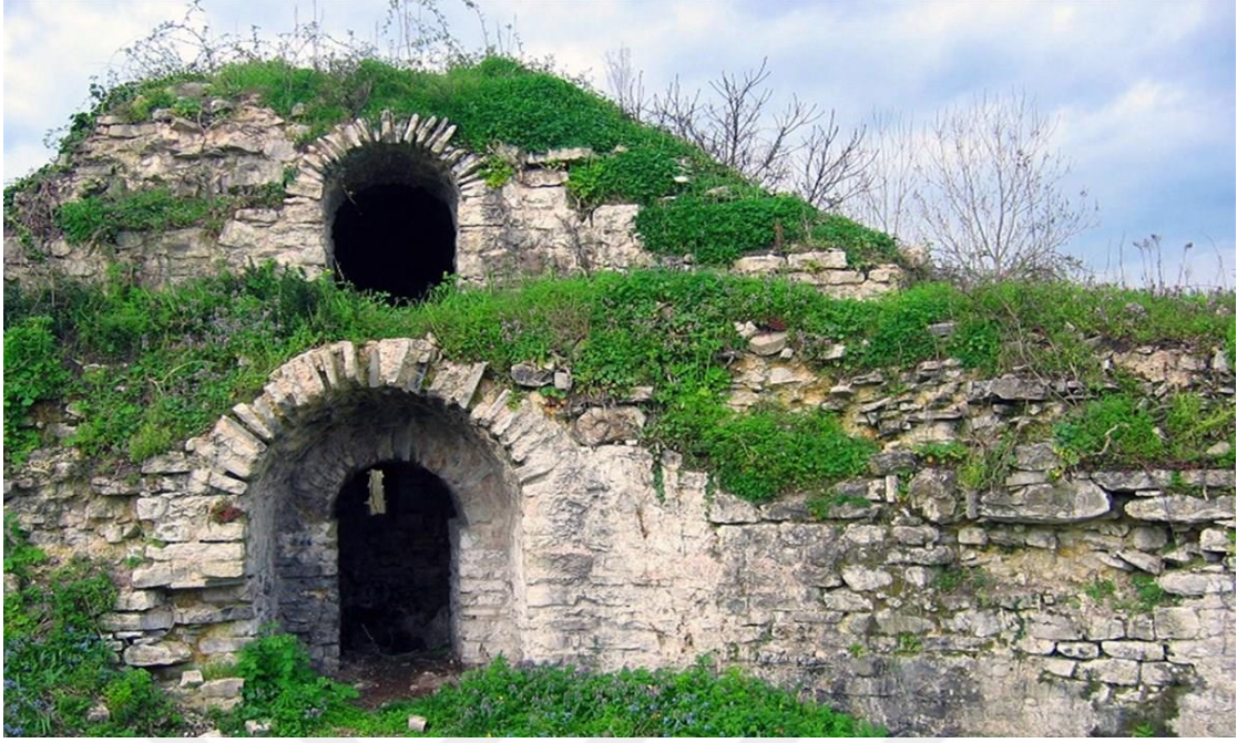
Görsel 4: Harmantepe Kalesi'nin İki Katlı Burçlarının Birinden Bir Görünüm
