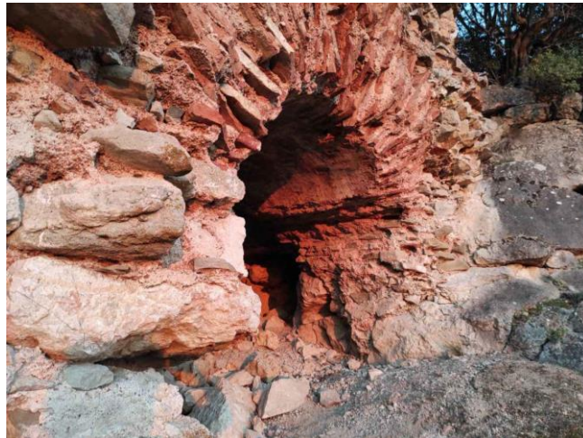
Görsel 21: Kalenin Güneybatı Tarafındaki Tuğla Kemerli Girişi
