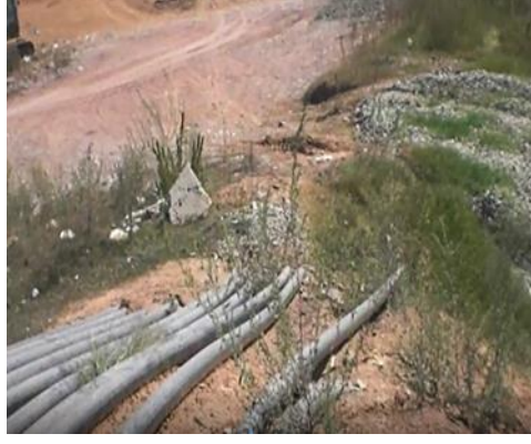
Şekil 5.29. Çöp sahasının yer altından gelen yatay gaz borular
