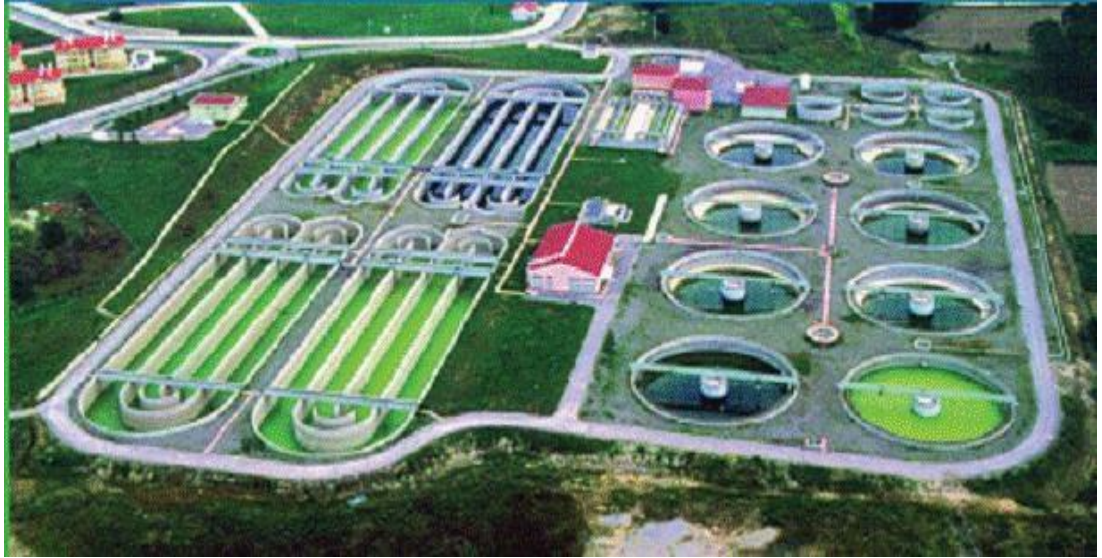
Şekil 3.1. Karaman atık su arıtma tesisi
