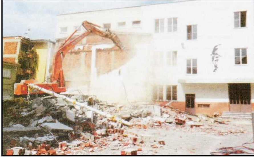
Resim 4. Deprem Sonrası Atatürk İlköğretim Okulu Yıkım Çalışmaları.
