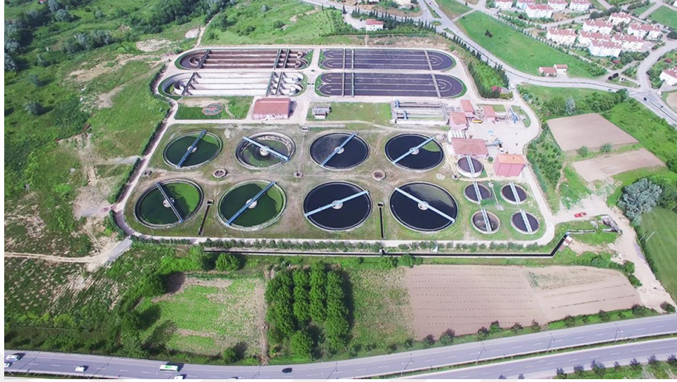
Şekil 3.1. Karaman Atıksu Arıtma Tesisi Genel Görünümü
