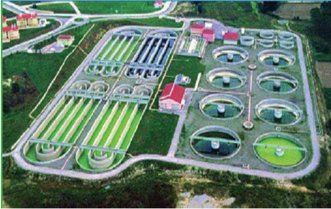
Şekil 4.1. SASKİ Arıtma Tesisinin Kuşbakışı Görünüşü [51]
