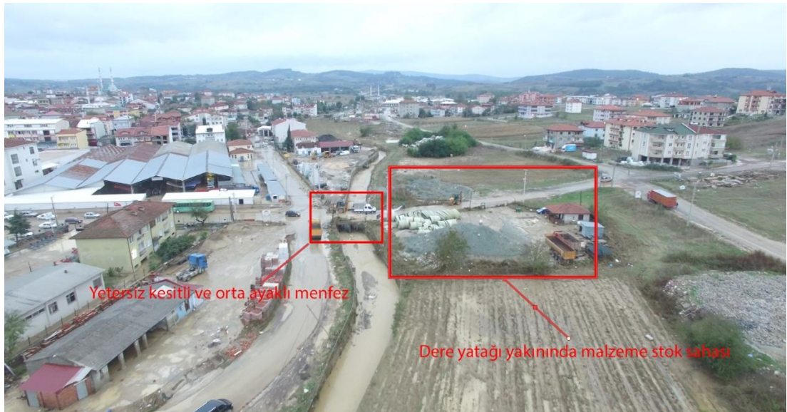
Şekil 2.2. Sakarya, Kaynarca, Seyran deresinde yetersiz kesitli geçiş yapısı ve uygunsuz stok sahası
