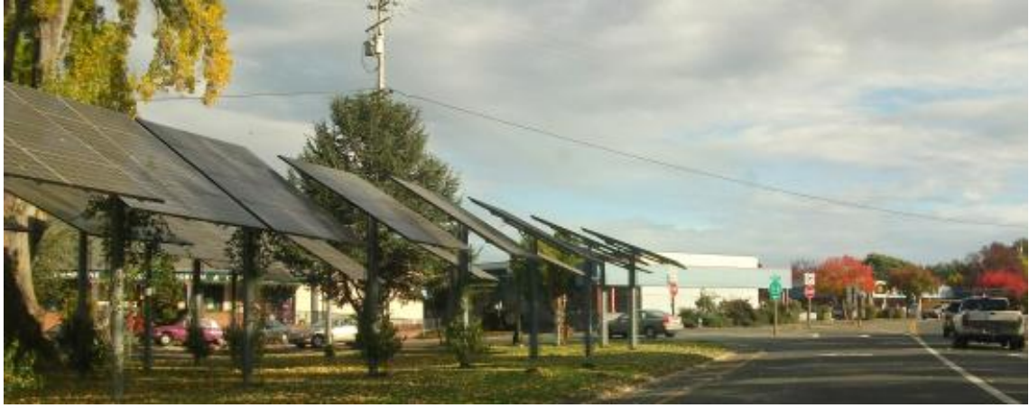
Şekil 2.11. Sebastopol güneş enerjisi panelleri (Tom Lane 2011)
