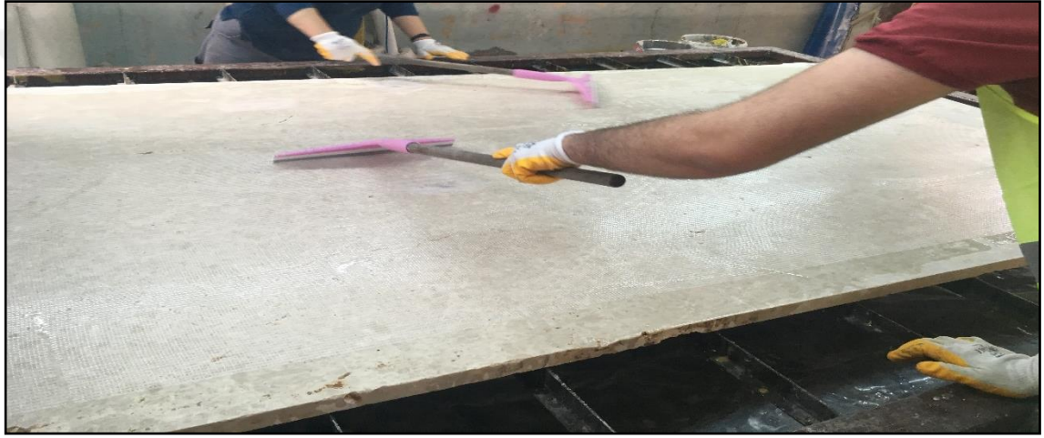
Şekil 3.13. Arka yüzeye epoksi+file uygulama
