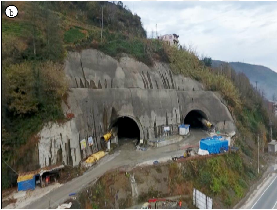
Şekil 3. Salarha Tünelinin (a) giriş ve (b) çıkış bölümlerinin araziden görünümü
