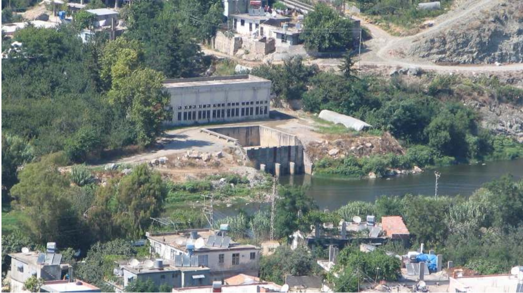
Foto 31: Asi nehrinden alınan sular Sutaşı köyü pompa istasyonu ve diğer istasyonlar vasıtasıyla kanaletlere aktarılmakta ve Samandağ ovası bu kanaletlerle sulanmaktadır.
