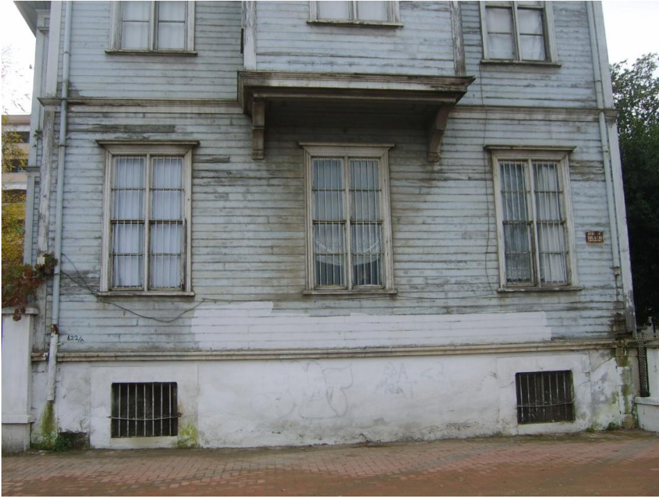
Resim 4.2-2. Kuzeydoğu cephesi (A görünüşü) – genel görünüm
