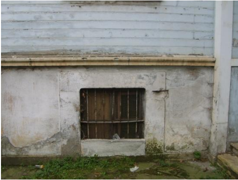
Resim 4.9-3. Kuzeybatı cephesi (C görünüşü) – D1 duvarı P5-1 penceresi
