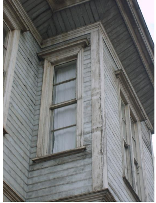
Resim 4.7-6. Kuzeybatı cephesi (C görünüşü) – D12 duvarı, P3-8 penceresi
