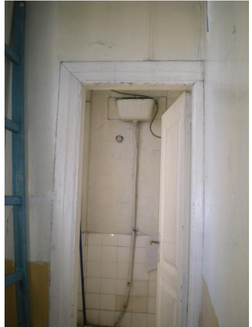
Resim 4.51-5. Lavabo – 103 mekânı D1 duvarı K8-3 kapısı yönüne bakış
