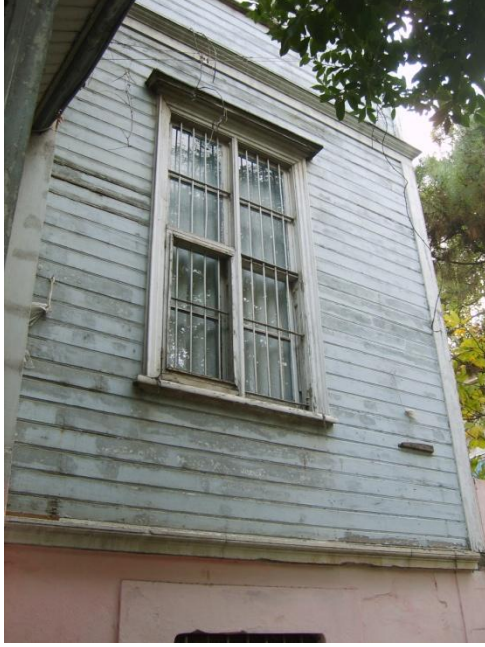
Resim 4.7-2. Kuzeybatı cephesi (C görünüşü) – D6 duvarı P2-9 penceresi
