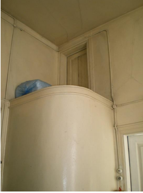
Resim 4.54-1. Mutfak – 106 mekânı D4, D5 duvar, pencere yönüne bakış
