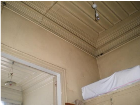
Resim 4.8-3. Hol – Z03 mekânı D3, D4 duvar yönüne bakış
