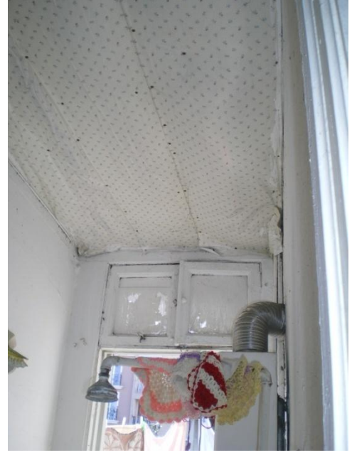
Resim 4.53-2. Banyo – 105 mekânı D1 duvarı K9-2 kapısı yönüne bakış
