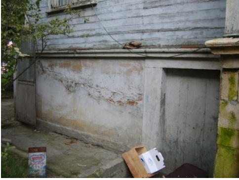
Resim 4.6-5. Güneybatı cephesi (B görünüşü) – D1 duvarı
