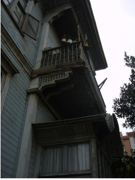
Resim 4.9-1. Kuzeydoğu cephesi (A görünüşü) – D4 duvarı K1-2 kapısı ve balkon
