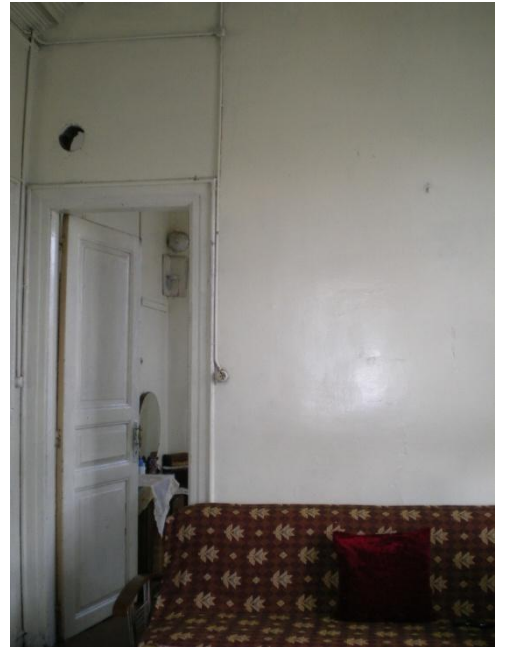
Resim 4.14-2. Oda – Z05 mekânı D2 duvar yönüne bakış
