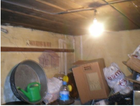
Resim 4.89-2. Hol – B04 mekânı D1, D2 duvar yönüne bakış
