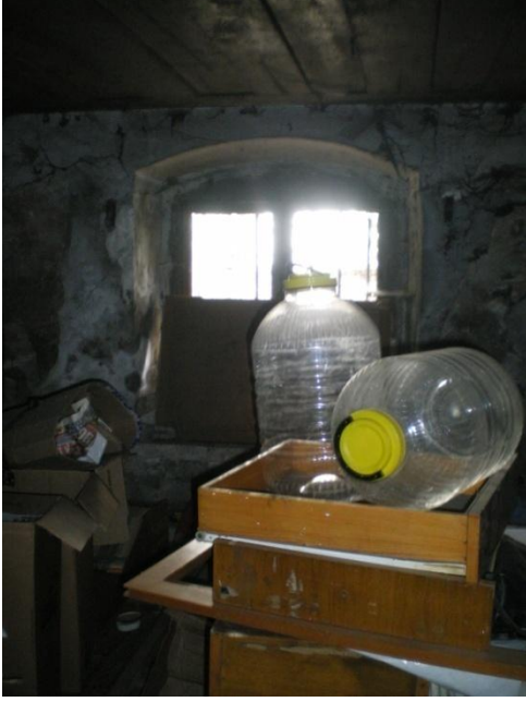
Resim 4.109-2. Odunluk – B09 mekânı D1, D2 duvar yönüne bakış
