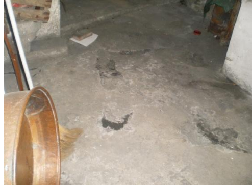
Resim 4.103-3. Odunluk – B08 mekânı döşeme yönüne bakış
