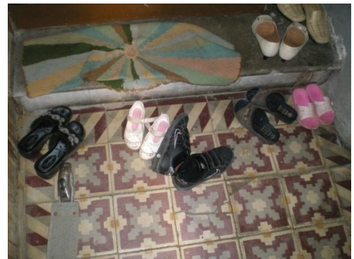
Resim 4.22-2. Giriş – Z07 mekânı döşeme yönüne bakış
