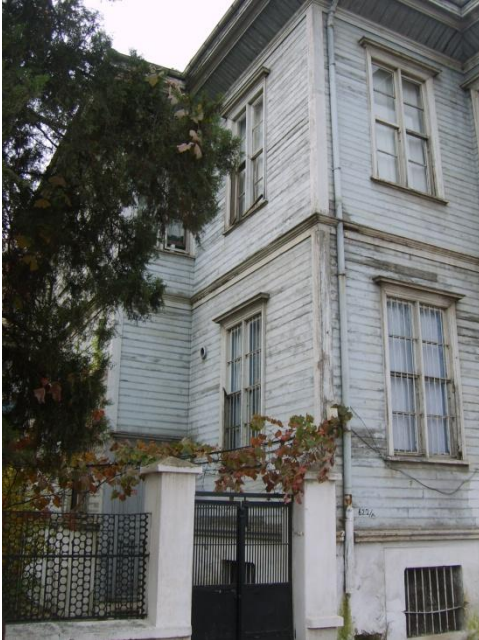
Resim 4.3-3. Kuzeydoğu, Güneydoğu cephesi (A,D görünüşü) – genel görünüm
