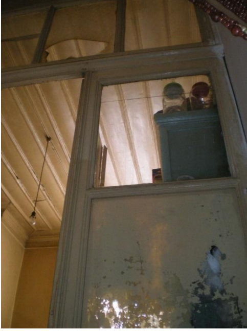
Resim 4.27-2. Hol – Z08 mekânı D1 duvar yönüne bakış
