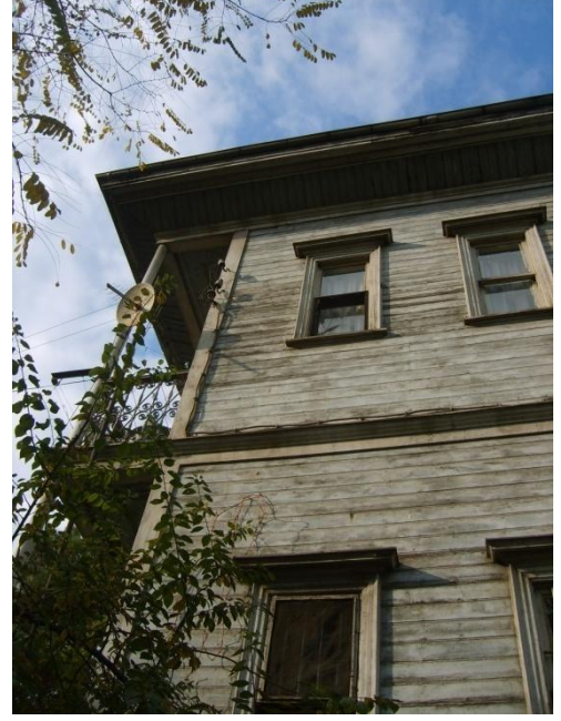
Resim 4.4-6. Güneydoğu cephesi (D görünüşü) – D7 duvarı P3-6,7 pencereleri
