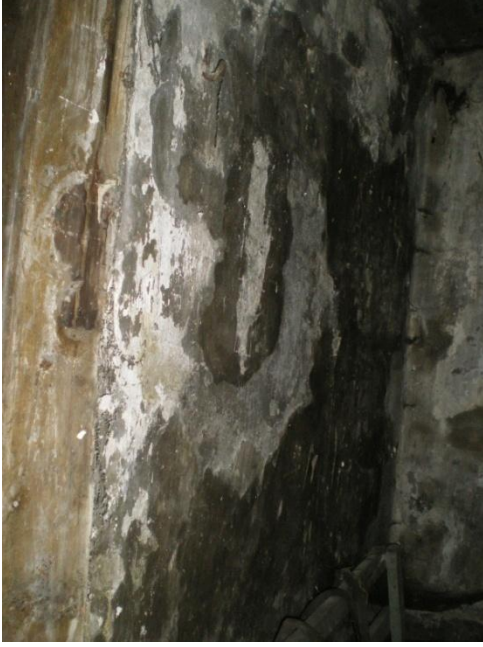
Resim 4.101-3. Odunluk – B07 mekânı D4 duvarı yönüne bakış
