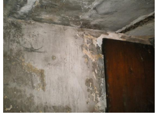
Resim 4.97-1. Odunluk – B06 mekânı D2 duvar yönüne bakış
