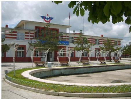
Resim 5.33. Sivas İstasyonu gar ve lojman binası dış görünümü
