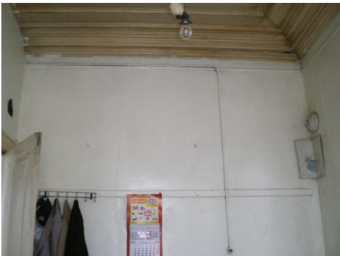
Resim 4.10-1. Oda – Z04 mekânı D1 duvar yönüne bakış
