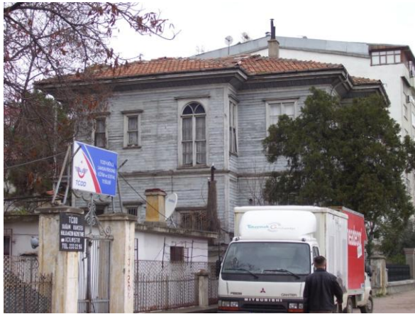
Resim 4.3-5. Güneydoğu cephesi (D görünüşü) – genel görünüm
