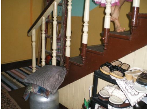
Resim 4.24-3. Giriş – Z07 mekânı merdiven, korkuluk ve küpeşte yönüne bakış
