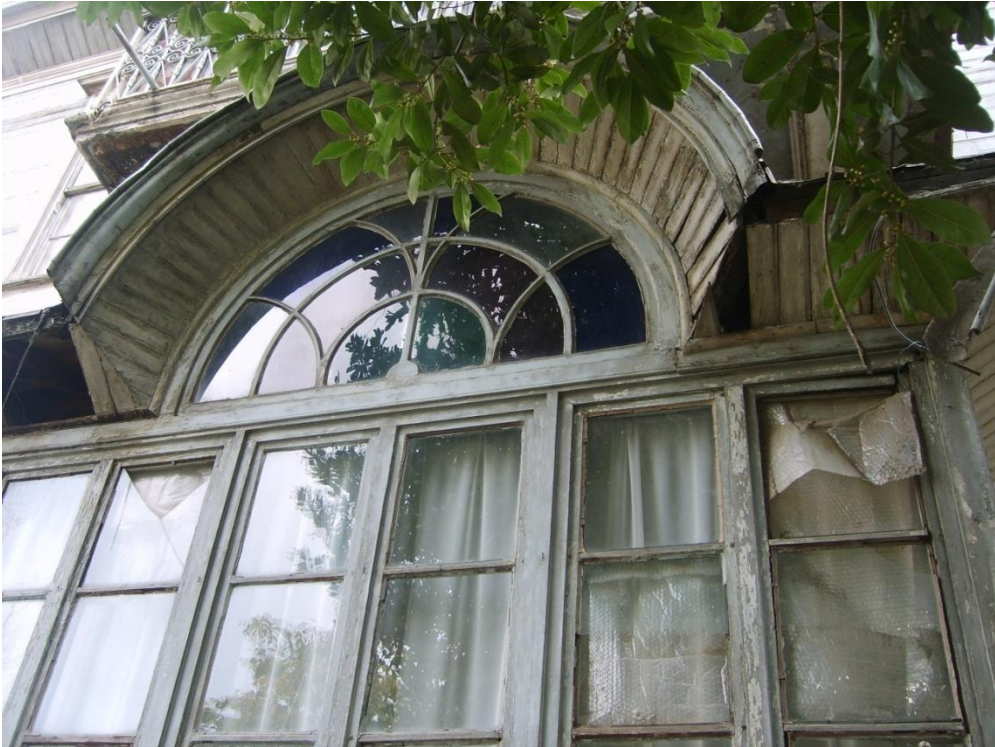
Resim 4.8-1. Kuzeybatı cephesi (C görünüşü) – D2 duvarı P1 rüzgârlık penceresi
