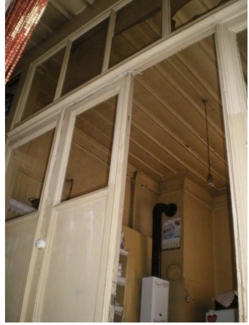
Resim 4.27-3. Hol – Z08 mekânı D1 duvar yönüne bakış
