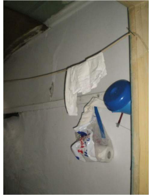
Resim 4.35-1. Kiler – Z12 mekânı D4 duvar yönüne bakış
