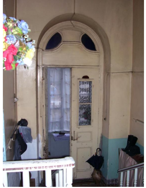
Resim 4.7-1. Giriş – Z02 mekânı D2 duvarı K2 kapısına bakış
