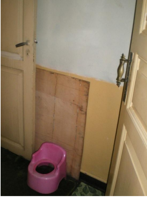
Resim 4.50-2. Hol – 102 mekânı D3 duvar yönüne bakış
