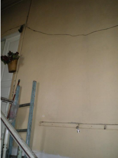
Resim 4.6-2. Giriş – Z02 mekânı D1 duvar yönüne bakış
