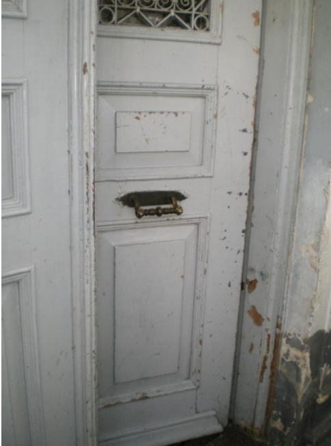
Resim 4.2-6. Rüzarlık – Z01 mekânı D4 duvarı K2 kapısına bakış
