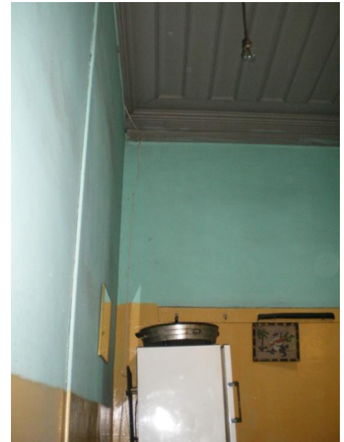
Resim 4.24-2. Giriş – Z07 mekânı D1, D2 duvar yönüne bakış
