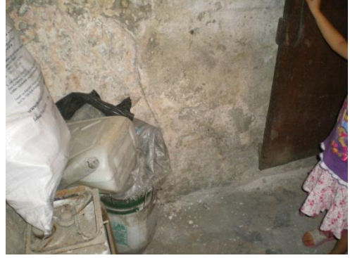
Resim 4.97-3. Odunluk – B06 mekânı D2 duvar yönüne bakış
