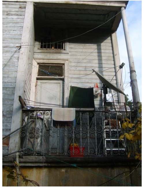
Resim 4.5-1. Güneybatı cephesi (B görünüşü) – D6 duvarı K9-1 kapısı
