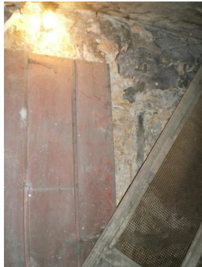
Resim 4.98-2. Odunluk – B06 mekânı D3 duvar yönüne bakış
