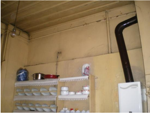
Resim 4.37-2. Mutfak – Z13 mekânı D4 duvar yönüne bakış
