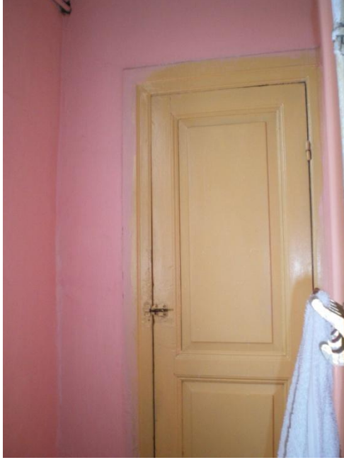
Resim 4.33-1. Lavabo – Z10 mekânı D1 duvarı K8-1 kapısı yönüne bakış
