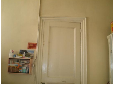
Resim 4.56-2. Mutfak – 106 mekânı D2 duvarı K4-11 kapısı yönüne bakış
