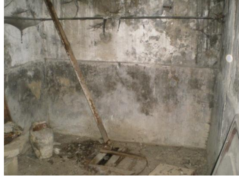
Resim 4.100-1. Odunluk – B07 mekânı D2, D3 duvar yönüne bakış
