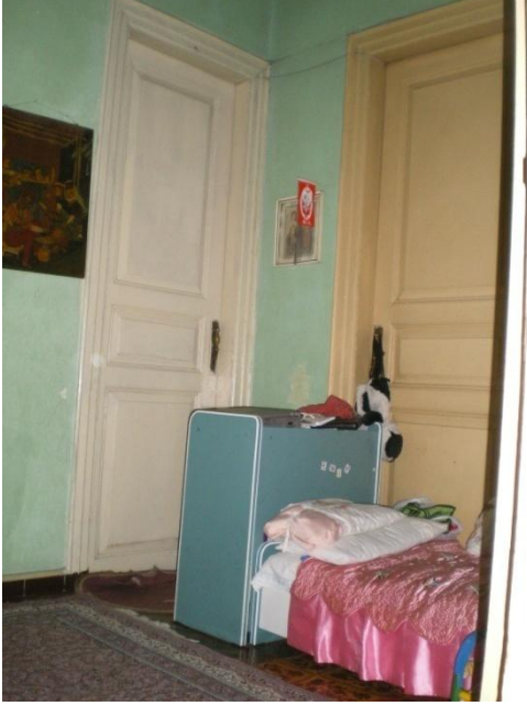
Resim 4.67-2. Hol – 109 mekânı D2 duvarı K4-5 kapısı yönüne bakış
