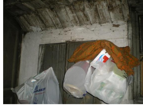
Resim 4.78-2. Hol – B01 mekânı D2 duvarı, P8 penceresi yönüne bakış
