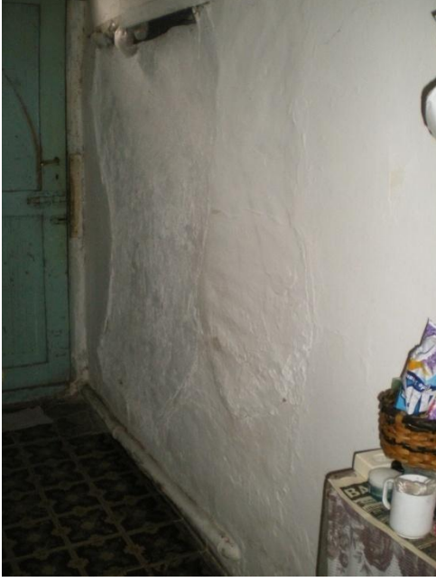
Resim 4.35-2. Kiler – Z12 mekânı D2 duvar yönüne bakış
