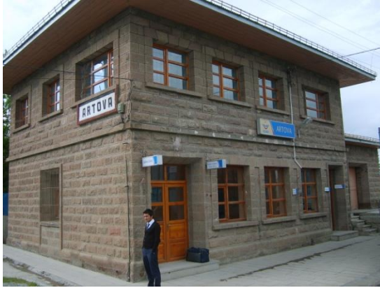
Resim 5.19. Artova İstasyonu gar ve lojman binası dış görünümü (2011)
