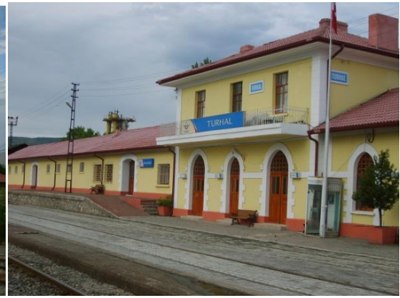
Resim 5.14. Turhal İstasyonu gar ve lojman binası görünümü
