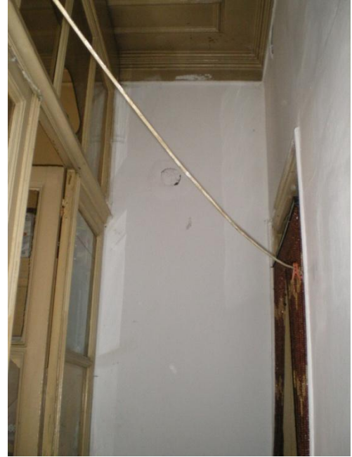
Resim 4.28-1. Hol – Z08 mekânı D2 duvar yönüne bakış
