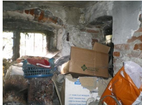
Resim 4.103-1. Odunluk – B08 mekânı D1, D2 duvar yönüne bakış
