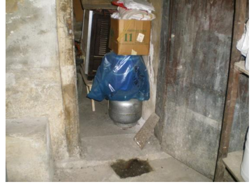
Resim 4.84-2. Odunluk – B03 mekânı D1 duvarı K15-1 kapısı yönüne bakış
