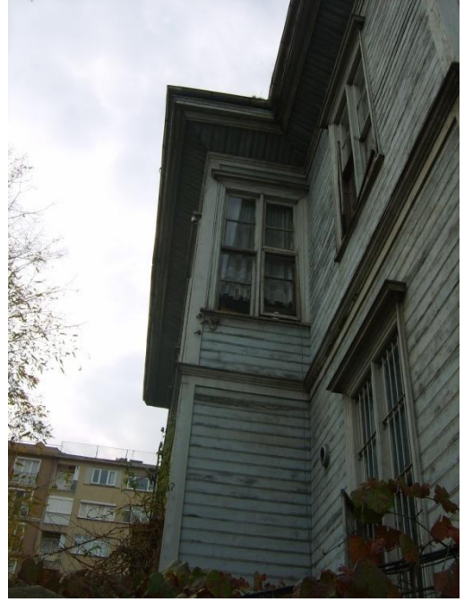
Resim 4.3-2. Kuzeydoğu cephesi (A görünüşü) – D5 duvarı - P2-15 penceresi
