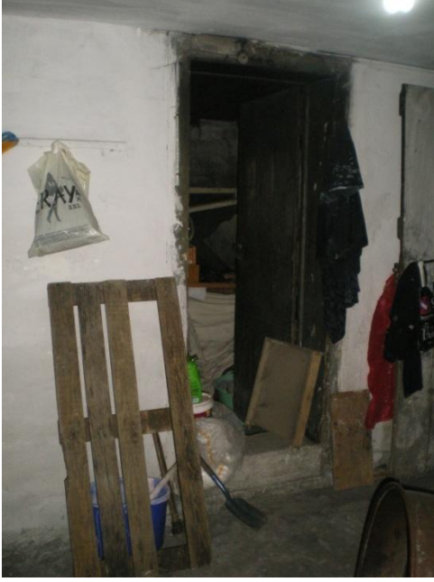
Resim 4.105-5. Odunluk – B08 mekânı D4 duvarı K14-3 kapısı yönüne bakış
