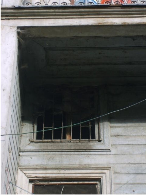
Resim 4.5-2. Güneybatı cephesi (B görünüşü) – D6 duvarı K9-1 kapı üstü penceresi
