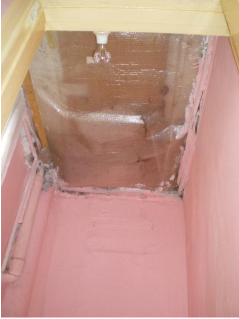
Resim 4.34-1. Helâ – Z11 mekânı D1, D2, D4 duvar yönüne bakış
