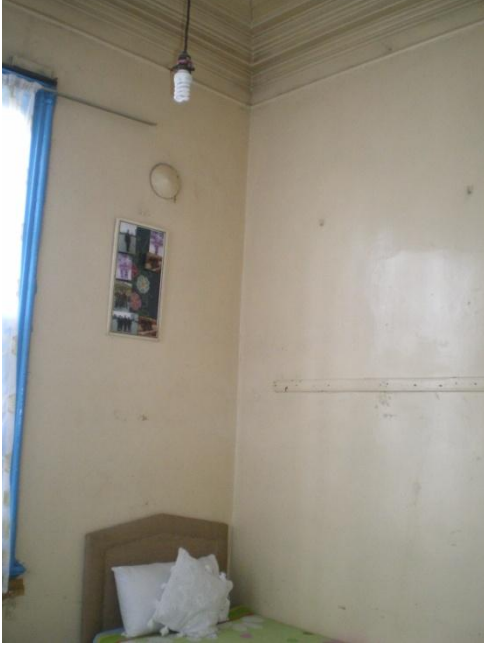
Resim 4.21-1. Oda – Z06 mekânı D1, D4 duvarları yönüne bakış
