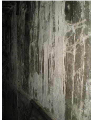
Resim 4.101-2. Odunluk – B07 mekânı D4 duvar yönüne bakış
