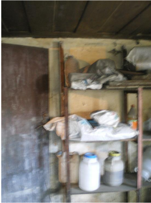
Resim 4.85-2. Odunluk – B03 mekânı D2 duvar yönüne bakış
