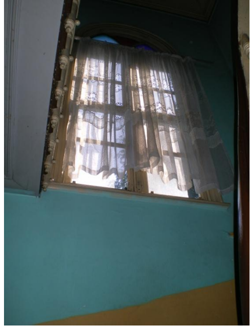
Resim 4.26-1. Giriş – Z07 mekânı D6 duvar yönüne bakış
