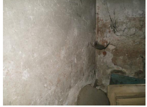
Resim 4.111-1. Odunluk – B09 mekânı D3,D4 duvar yönüne bakış
