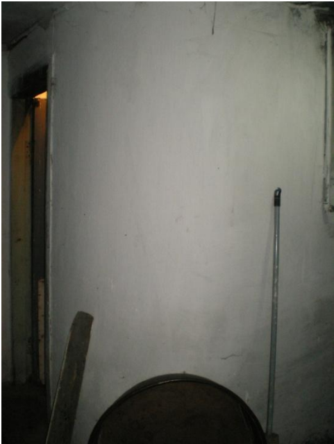
Resim 4.106-2. Odunluk – B08 mekânı D6, D7 duvar yönüne bakış
