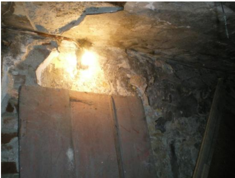
Resim 4.98-1. Odunluk – B06 mekânı D3 duvar yönüne bakış
