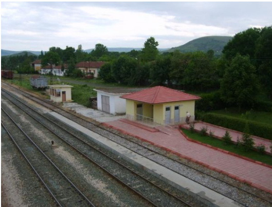
Resim 5.17. Zile İstasyon alanı görünüşü (2011)
