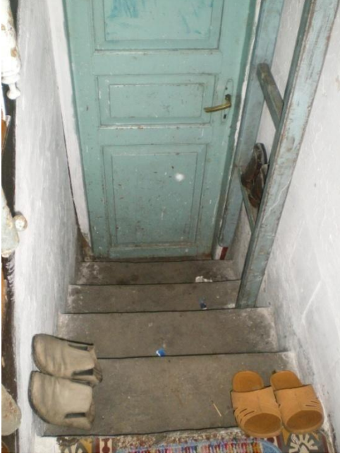
Resim 4.6-4. Giriş – Z02 mekânı D4 duvarı K4-13 kapısına bakış
