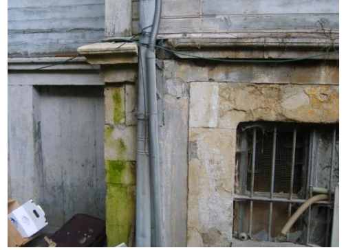
Resim 4.6-6. Güneybatı cephesi (B görünüşü) – bodrum kat
