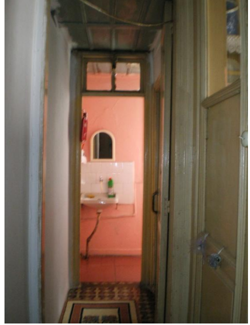
Resim 4.29-2. Hol – Z09 mekânı D4 duvarı K7-1 kapısı yönüne bakış
