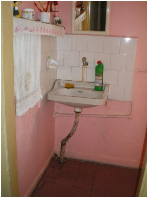
Resim 4.31-2. Lavabo – Z10 mekânı D3, D4 duvarı yönüne bakış
