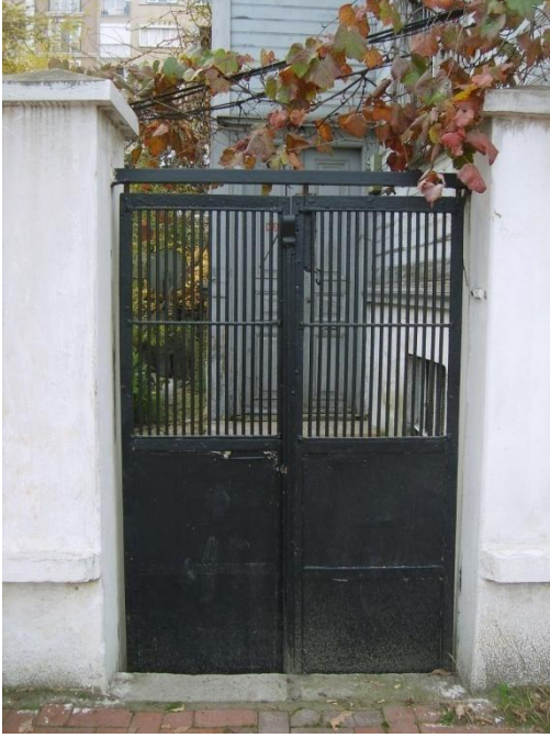
Resim 4.3-1. Kuzeydoğu cephesi (A görünüşü) – bahçe kapısı
