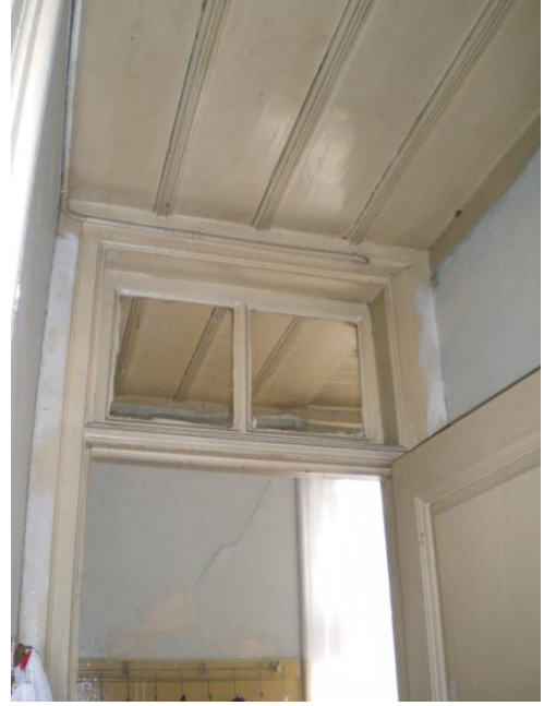
Resim 4.49-1. Hol – 102 mekânı duvarı K7-2 kapı yönüne bakış
