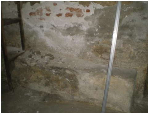
Resim 4.84-3. Odunluk – B03 mekânı D1 duvar yönüne bakış
