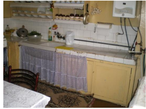
Resim 4.37-3. Mutfak – Z13 mekânı D4 duvar yönüne bakış
