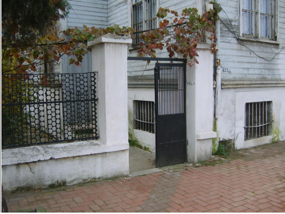
Resim 4.3-4. Kuzeydoğu cephesi (A görünüşü) – genel görünüm
