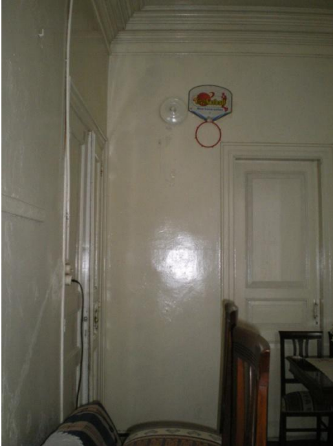
Resim 4.41-1. Oda – Z14 mekânı D4 duvarı K4-4 kapısı yönüne bakış
