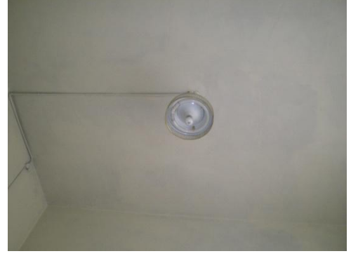
Resim 4.70-3. Oda – 111 mekânı tavan yönüne bakış
