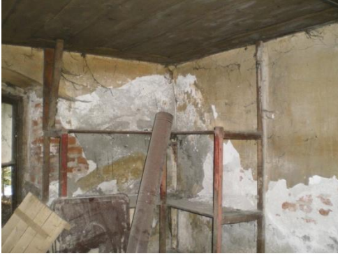
Resim 4.84-5. Odunluk – B03 mekânı D1, D4 duvar yönüne bakış
