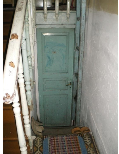
Resim 4.6-3. Giriş – Z02 mekânı D4 duvarı K4-13 kapısına bakış
