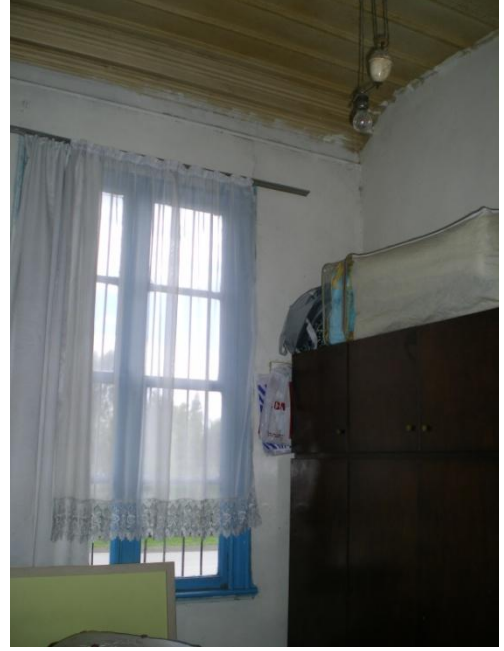
Resim 4.12-1. Oda – Z04 mekânı D3 duvarı P2-2 penceresine bakış
