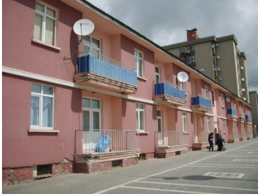
Resim 5.35. Sivas İstasyonu lojman binaları dış görünümü (2011)
