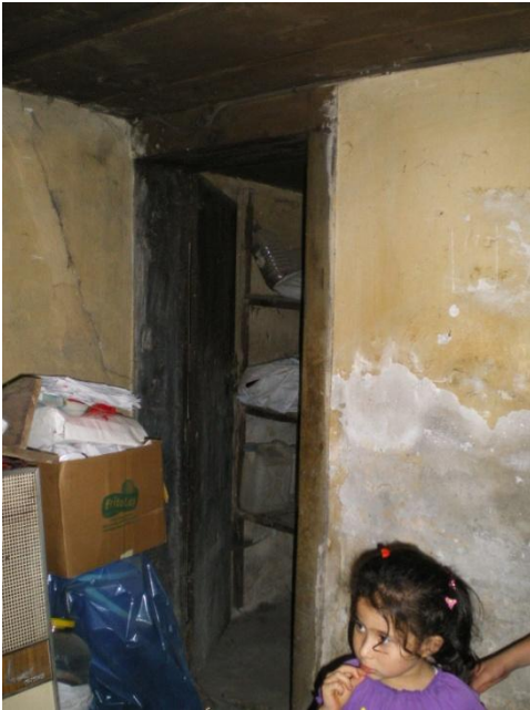
Resim 4.90-1. Hol – B04 mekânı D3 duvarı K15-1 kapısı yönüne bakış
