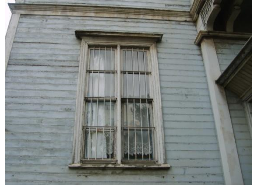
Resim 4.8-4. Kuzeybatı cephesi (C görünüşü) – D5 duvarı P2-1 penceresi
