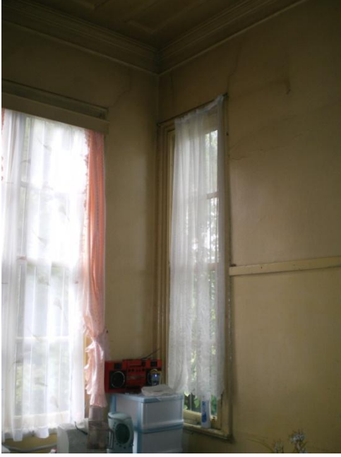
Resim 4.39-1. Mutfak – Z13 mekânı D2 duvarı P3-3 penceresi yönüne bakış
