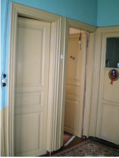
Resim 4.45-1. Antre – 101 mekânı D1 duvar yönüne bakış
