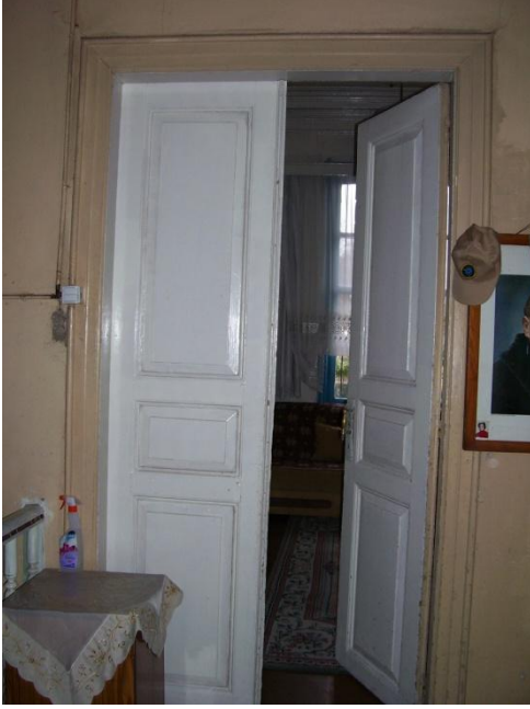
Resim 4.8-1. Hol – Z03 mekânı D3 duvarı K3-1 kapısına bakış
