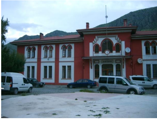
Resim 5.11. Amasya İstasyonu gar ve binası dış görünümü
