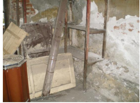
Resim 4.87-2. Odunluk – B03 mekânı D4 duvar yönüne bakış
