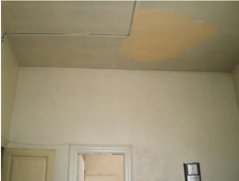
Resim 4.58-1. Oda – 107 mekânı D4 duvar yönüne bakış
