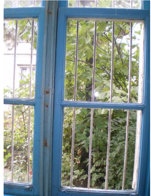
Resim 4.42-4. Oda – Z14 mekânı D1 duvarı P2-8 penceresi yönüne bakış
