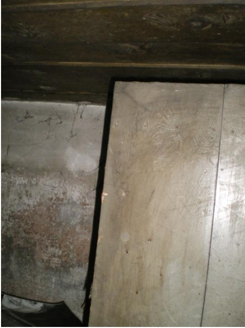
Resim 4.110-1. Odunluk – B09 mekânı D3 duvar yönüne bakış
