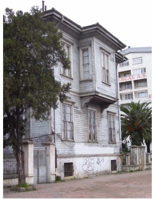
Resim 4.3-6. Kuzeydoğu cephesi (A görünüşü) – genel görünüm
