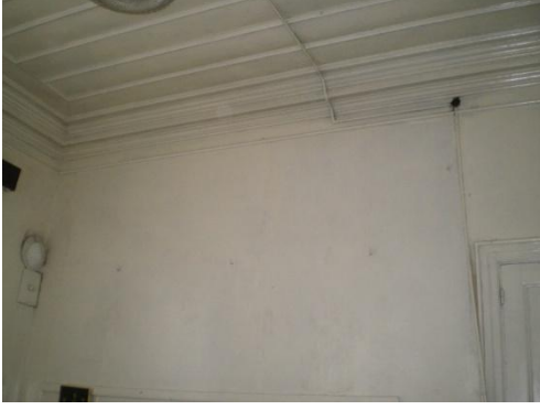
Resim 4.44-2. Oda – Z14 mekânı D3 duvar yönüne bakış
