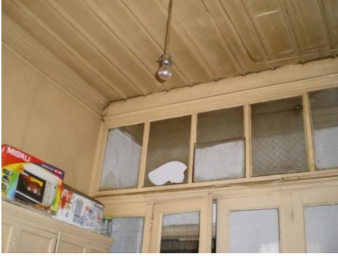
Resim 4.40-1. Mutfak – Z13 mekânı D3 duvarı K10 kapısı yönüne bakış
