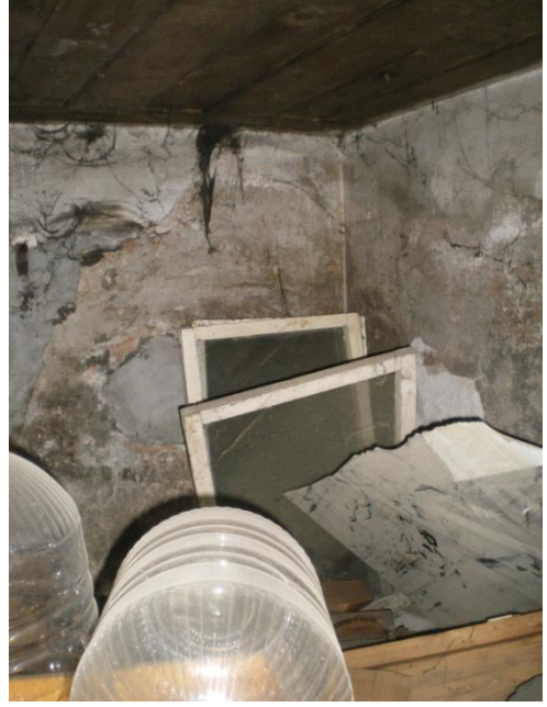
Resim 4.109-3. Odunluk – B09 mekânı D1 duvar yönüne bakış
