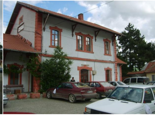
Resim 5.8. Havza İstasyonu gar ve lojman binası görünümü (2011)
