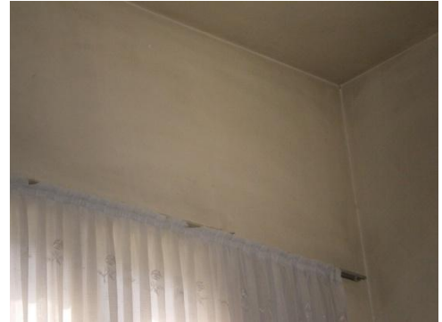
Resim 4.59-3. Oda – 107 mekânı D1 duvar yönüne bakış
