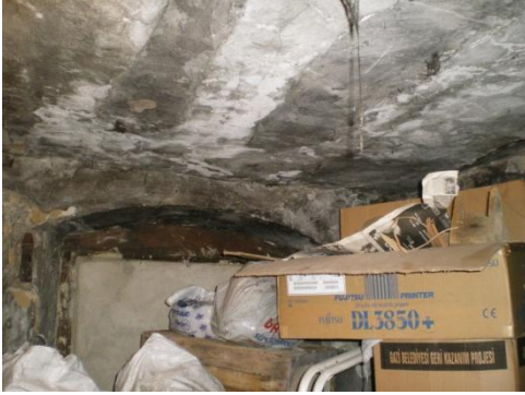
Resim 4.99-1. Odunluk – B06 mekânı D4 duvar yönüne bakış
