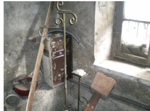
Resim 4.82-3. Odunluk – B02 mekânı D2, D3 duvar yönüne bakış
