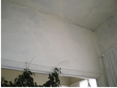
Resim 4.76-2. Oda – 112 mekânı D2 duvar yönüne bakış
