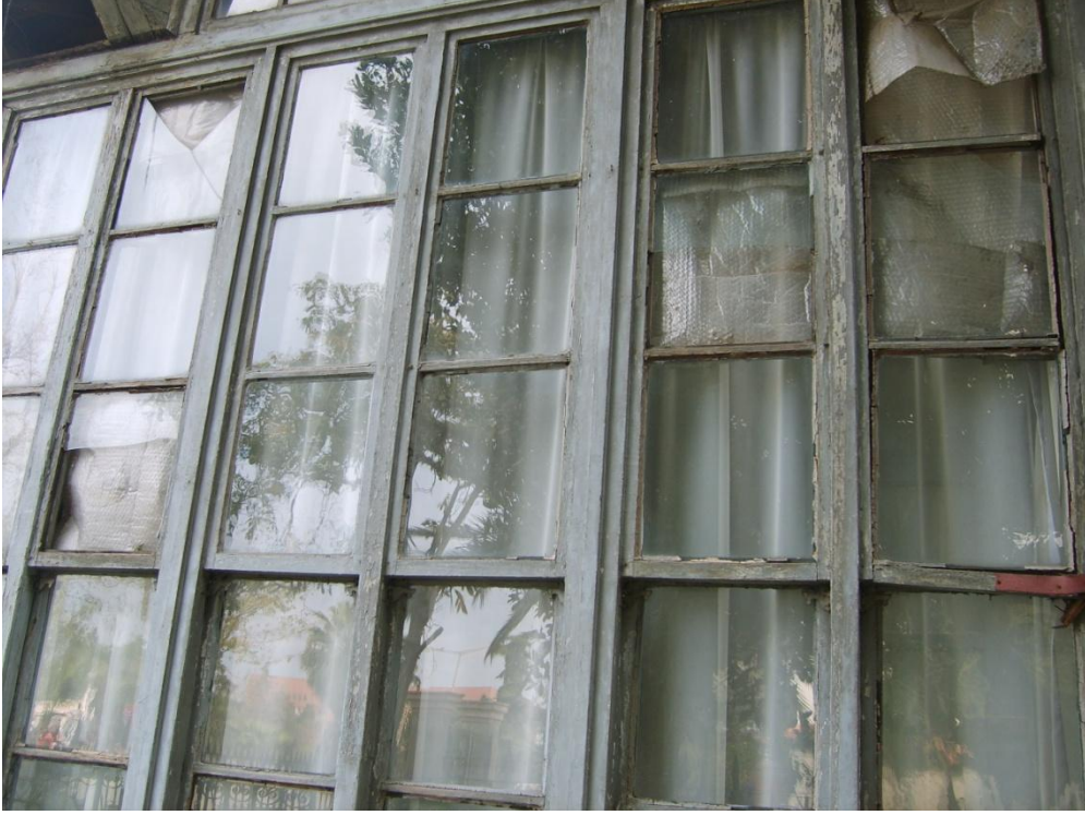
Resim 4.8-2. Kuzeybatı cephesi (C görünüşü) – D2 duvarı P1 rüzgârlık penceresi
