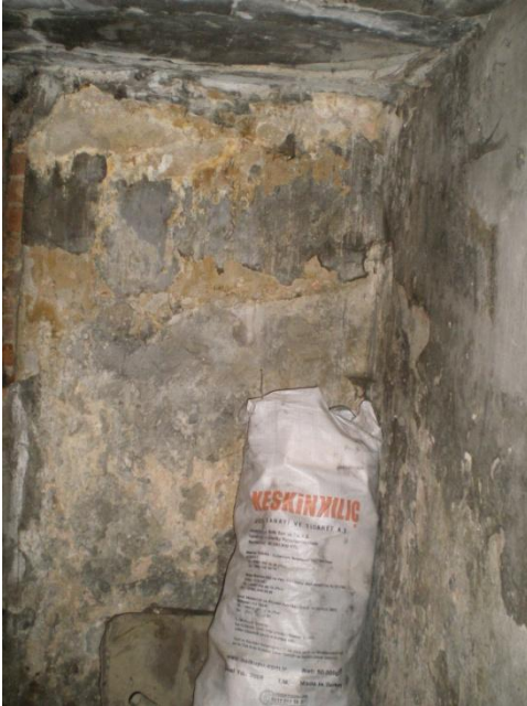
Resim 4.96-1. Odunluk – B06 mekânı D1 duvar yönüne bakış
