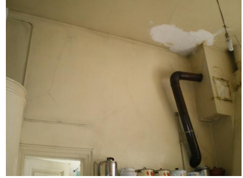
Resim 4.54-4. Mutfak – 106 mekânı D5, D6 duvar yönüne bakış
