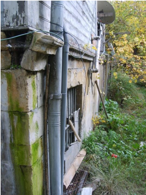
Resim 4.6-3. Güneybatı cephesi (B görünüşü) – D2 duvarı
