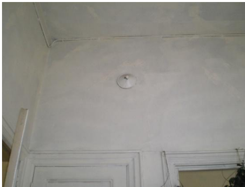
Resim 4.76-4. Oda – 112 mekânı D2 duvar yönüne bakış
