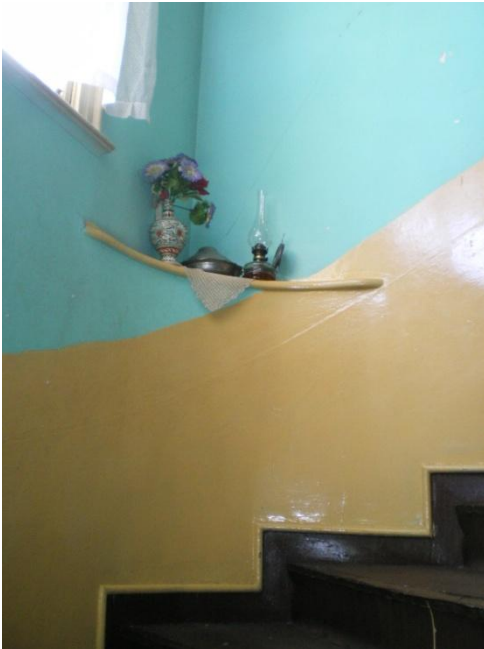
Resim 4.26-2. Giriş – Z07 mekânı D3, D6 duvar yönüne bakış
