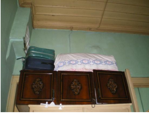
Resim 4.69-1. Hol – 109 mekânı D4 duvar yönüne bakış
