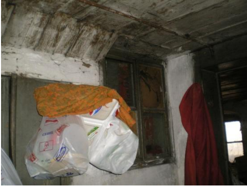
Resim 4.78-1. Hol – B01 mekânı D2, D3 duvar yönüne bakış
