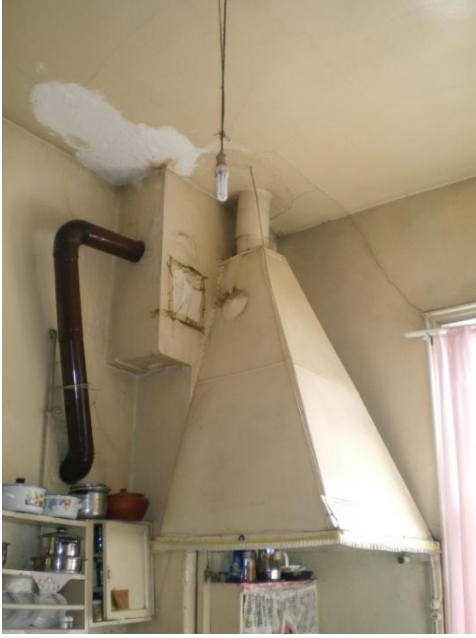
Resim 4.54-5. Mutfak – 106 mekânı D6, D7, D8, D1 duvar yönüne bakış
