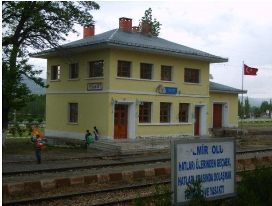
Resim 5.22. Yeşilyurt İstasyonu gar ve lojman binası dış görünümü
