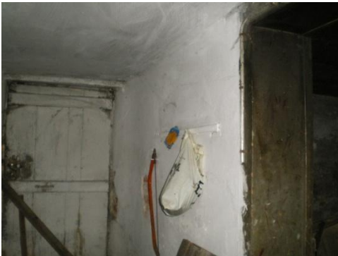
Resim 4.105-3. Odunluk – B08 mekânı D3, D4 duvar yönüne bakış
