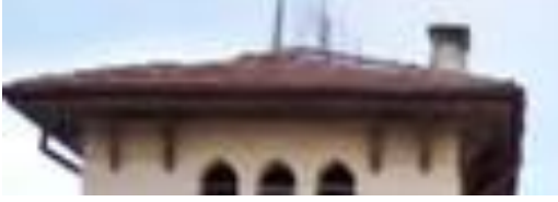
Resim 5.58. Malıköy Lojmanı saçak detayı
