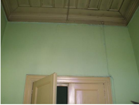
Resim 4.65-1. Oda – 108 mekânı D4 duvar yönüne bakış
