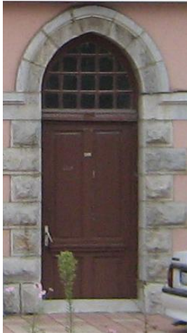
Resim 5.47. Kırıkkale Lojmanı tek kanatlı beşik kemerli giriş kapısı
