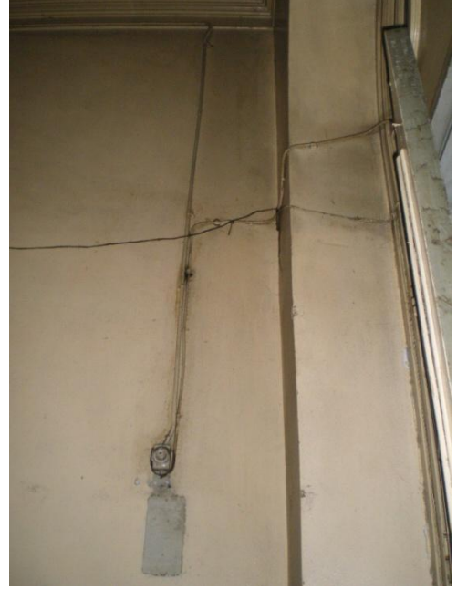
Resim 4.6-1. Giriş – Z02 mekânı D1, D2 duvar yönlerine bakış
