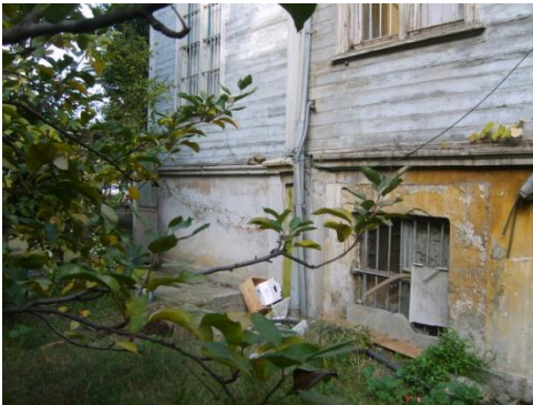
Resim 4.5-4. Güneybatı cephesi (B görünüşü) – D2 duvarı P5-6 penceresi
