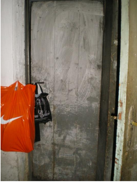
Resim 4.77-1. Hol – B01 mekânı D1 duvarı K15-3 kapısı yönüne bakış
