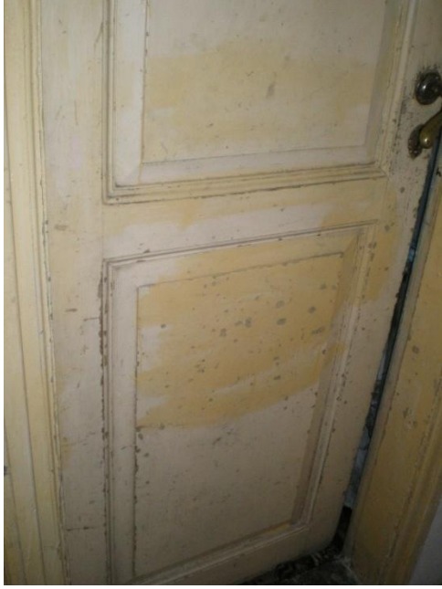
Resim 4.30-2. Hol – Z09 mekânı D1 duvarı K8-2 kapısı yönüne bakış
