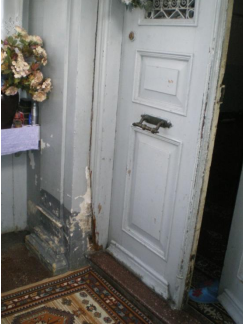
Resim 4.3-2. Rüzgarlık – Z01 mekânı D3-D4 duvar yönlerine bakış
