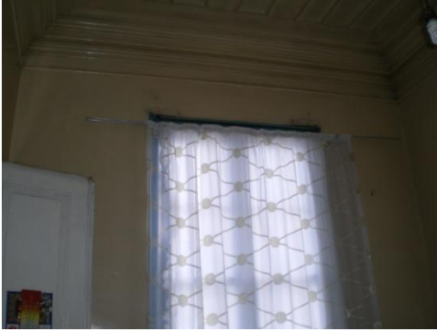
Resim 4.19-1. Oda – Z06 mekânı D3 duvarı P2-4 pencere yönüne bakış
