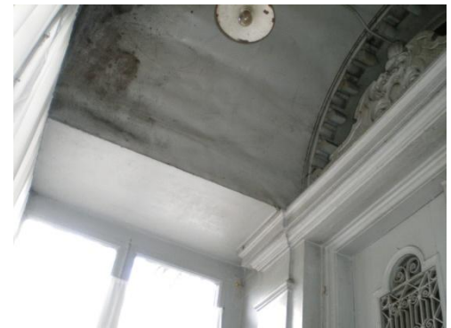
Resim 4.3-1. Rüzarlık – Z01 mekânı D3 duvar yönüne bakış
