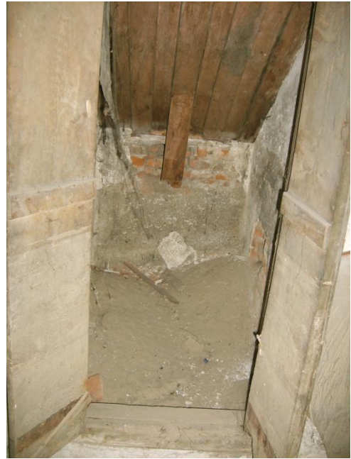
Resim 4.78-6. Odunluk – B10 mekânı D2, D3 duvarı, P8 penceresi yönüne bakış
