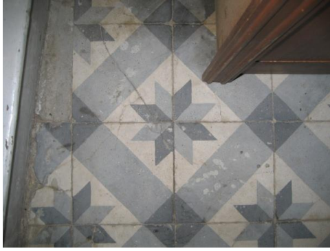
Resim 5.54. Konya Lojmanı giriş holü döşeme kaplaması
