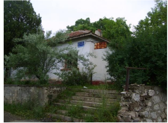
Resim 5.16. Zile İstasyonu lojman binası dış görünümü
