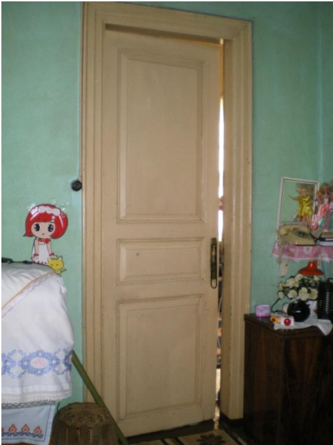
Resim 4.67-4. Hol – 109 mekânı D1 duvarı K4-12 kapısı yönüne bakış
