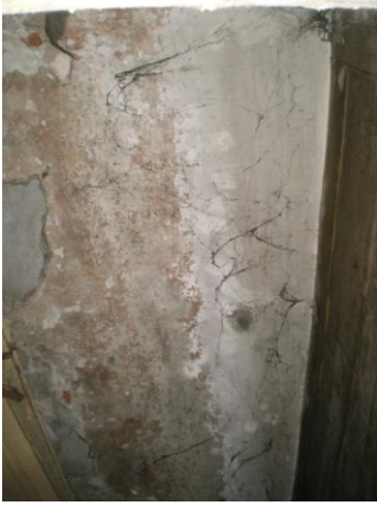
Resim 4.112-1. Odunluk – B09 mekânı D4 duvar yönüne bakış
