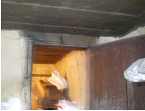
Resim 4.84-1. Odunluk – B03 mekânı D1 duvarı K15-1 kapısı yönüne bakış
