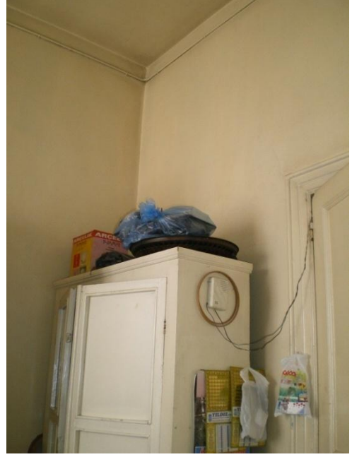
Resim 4.56-3. Mutfak – 106 mekânı D2, D3 duvar yönüne bakış
