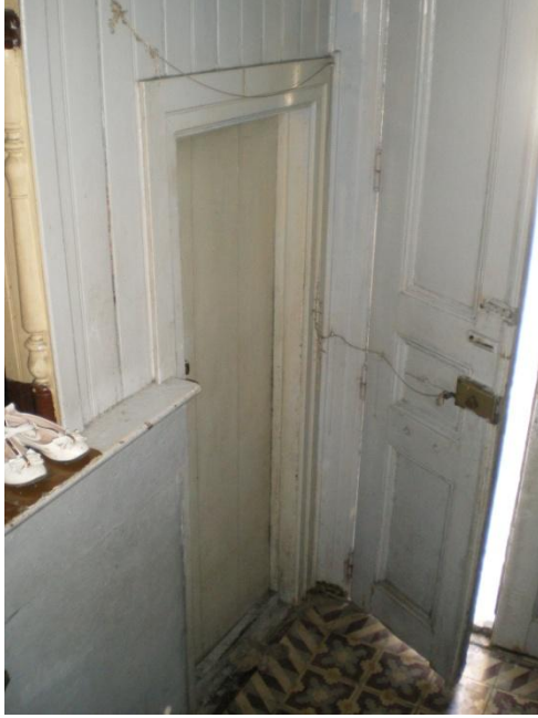
Resim 4.24-7. Giriş – Z07 mekânı D4 duvarı K6 kapısı yönüne bakış
