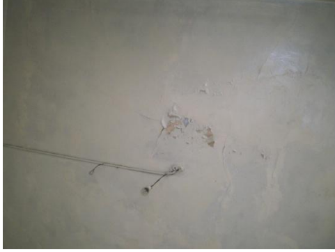
Resim 4.75-2. Oda – 112 mekânı tavan yönüne bakış
