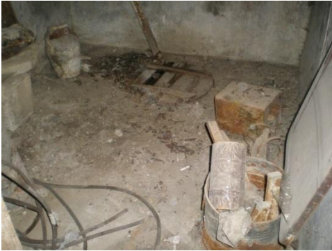
Resim 4.100-2. Odunluk – B07 mekânı döşeme yönüne bakış
