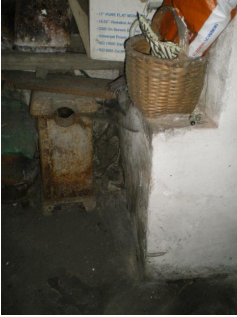
Resim 4.103-2. Odunluk – B08 mekânı D2 duvarı yönüne bakış
