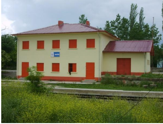
Resim 5.5. Bekdiğın İstasyonu gar ve lojman binası dış görünümü
