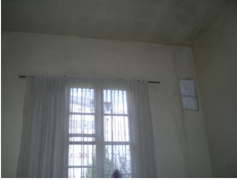
Resim 4.60-1. Oda – 107 mekânı D2 duvarı P2-18 penceresi yönüne bakış
