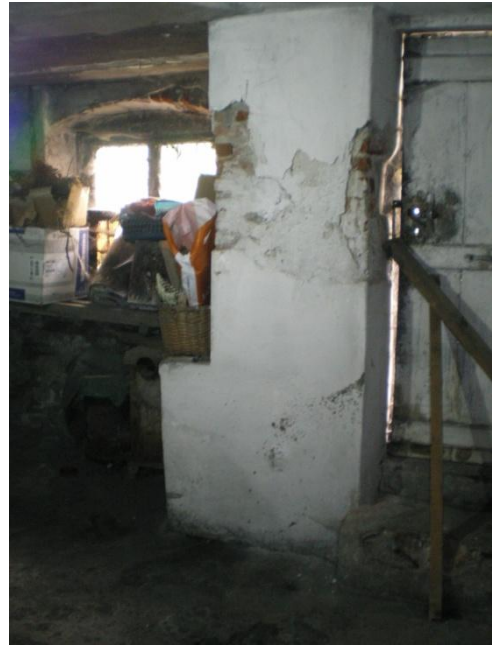
Resim 4.104-2. Odunluk – B08 mekânı D1, D3 duvar yönüne bakış
