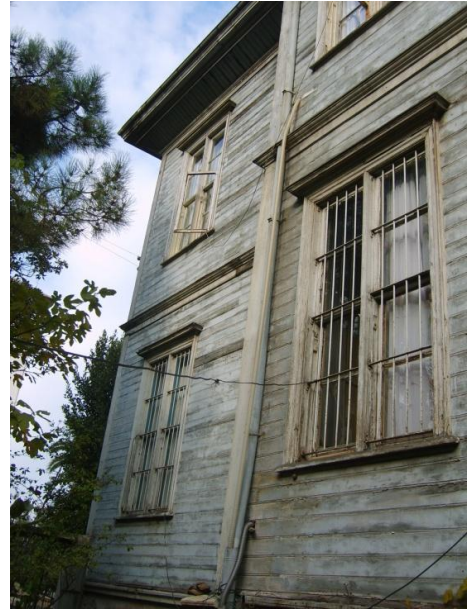
Resim 4.5-5. Güneybatı cephesi (B görünüşü) – genel görünüm
