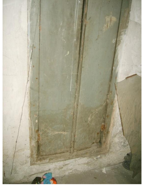
Resim 4.78-4. Hol – B01 mekânı D2 duvarı, P8 penceresi yönüne bakış
