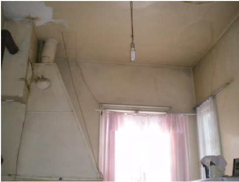
Resim 4.55-2. Mutfak – 106 mekânı D1, D2 duvar yönüne bakış
