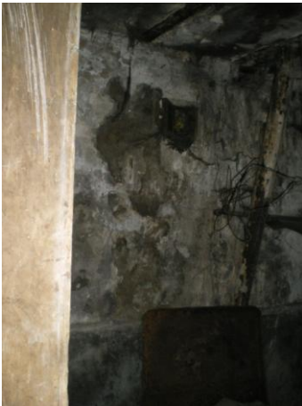
Resim 4.101-1. Odunluk – B07 mekânı D4 duvar yönüne bakış
