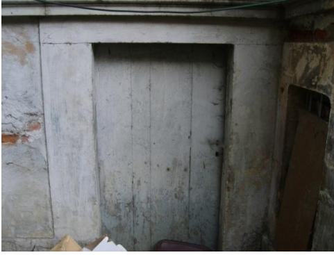
Resim 4.6-1. Güneybatı cephesi (B görünüşü) –D1 duvarı K15-4 kapısı
