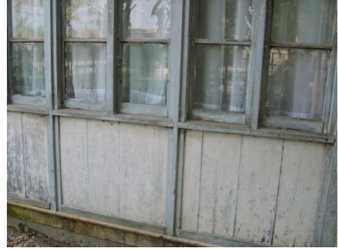
Resim 4.7-3. Kuzeybatı cephesi (C görünüşü) – D2 duvarı P1 rüzgârlık penceresi
