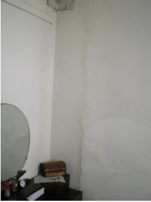
Resim 4.11-2. Oda – Z04 mekânı D2 duvar yönüne bakış
