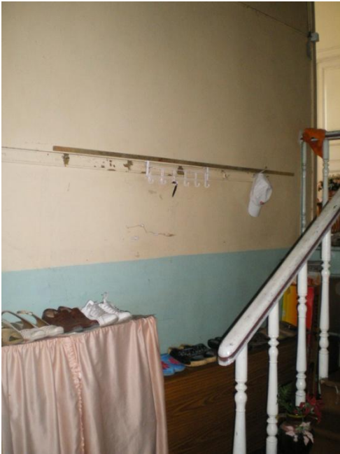
Resim 4.4-1. Giriş – Z02 mekânı D3 duvar yönüne bakış
