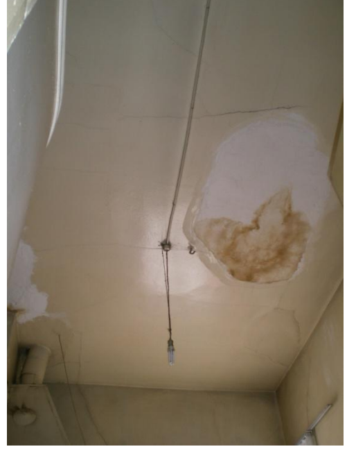
Resim 4.57-2. Mutfak – 106 mekânı tavan yönüne bakış
