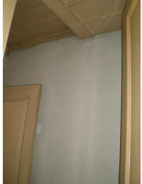
Resim 4.50-1. Hol – 102 mekânı D3 duvar yönüne bakış
