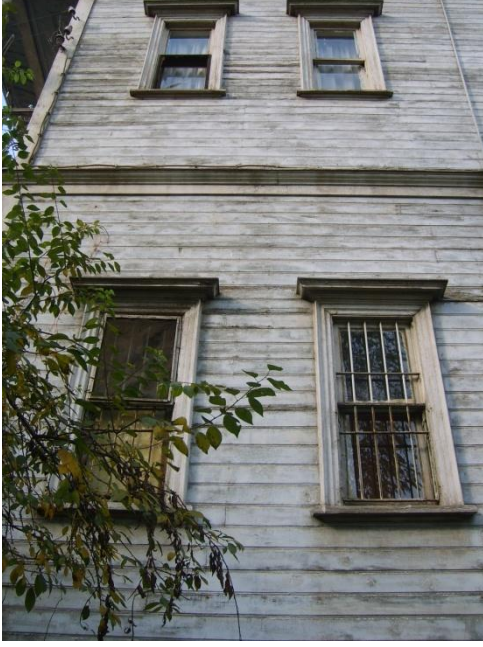
Resim 4.4-1. Güneydoğu cephesi (D görünüşü) – genel görünüm
