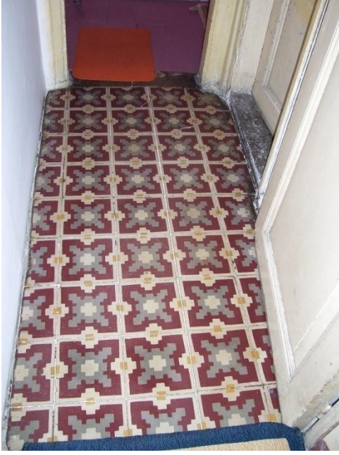
Resim 4.29-1. Hol – Z09 mekânı döşeme yönüne bakış
