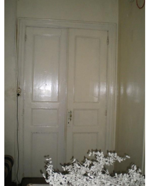
Resim 4.44-1. Oda – Z14 mekânı D3 duvarı K3-3 kapısı yönüne bakış
