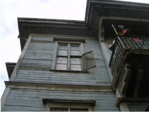
Resim 4.8-3. Kuzeybatı cephesi (C görünüşü) – D9 duvarı, P2-10 penceresi
