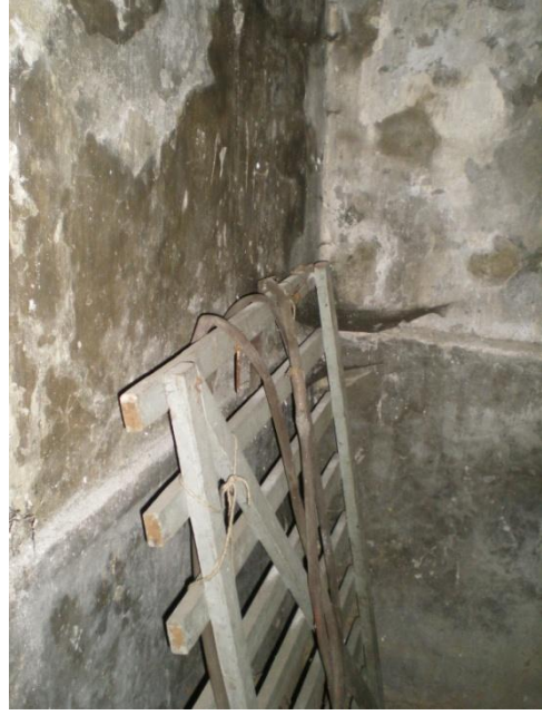
Resim 4.101-4. Odunluk – B07 mekânı D4 duvarı yönüne bakış
