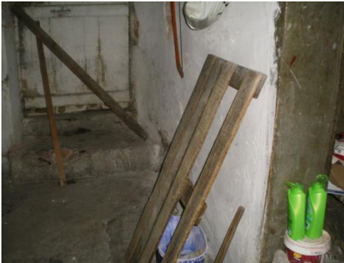
Resim 4.104-1. Odunluk – B08 mekânı D3 duvarı K15-4 kapısı yönüne bakış
