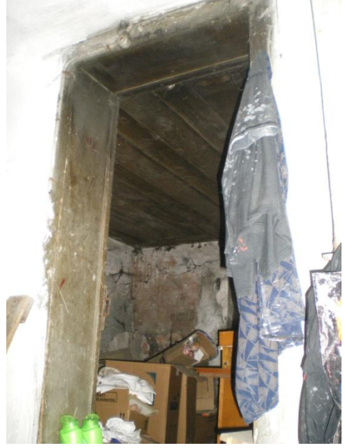
Resim 4.105-2. Odunluk – B08 mekânı D4 duvarı K14-3 kapısı yönüne bakış
