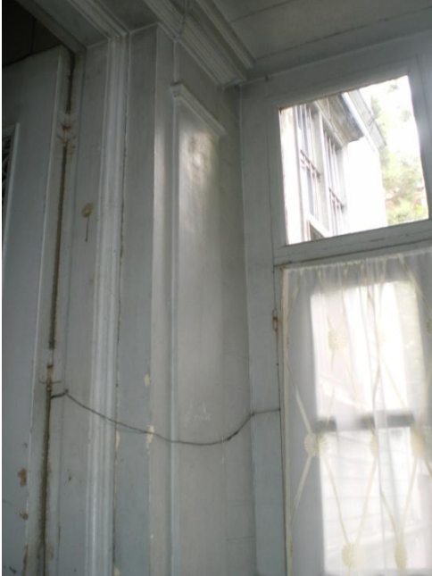
Resim 4.2-2. Rüzgarlık – Z01 mekânı D1-D4 duvar yönlerine bakış
