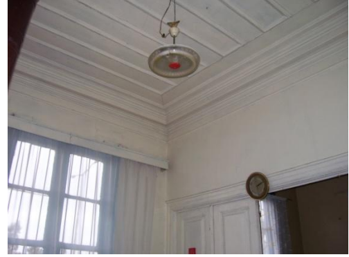
Resim 4.15-1. Oda – Z05 mekânı D3, D4 duvar yönlerine bakış
