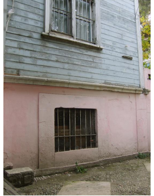
Resim 4.7-1. Kuzeybatı cephesi (C görünüşü) – D3 duvarı P5-7 penceresi
