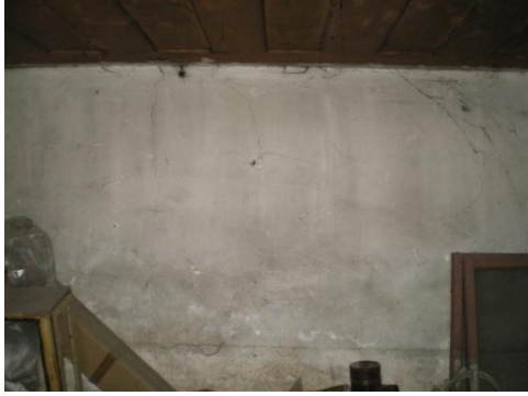
Resim 4.83-1. Odunluk – B02 mekânı D4 duvar yönüne bakış
