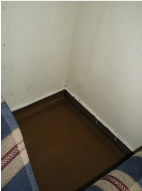
Resim 4.43-3. Oda – Z14 mekânı döşeme yönüne bakış
