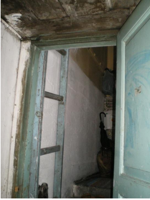
Resim 4.78-7. Hol – B01 mekânı D2 duvarı, K4-13 kapısı yönüne bakış
