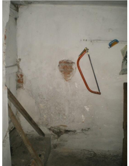
Resim 4.105-4. Odunluk – B08 mekânı D4 duvar yönüne bakış
