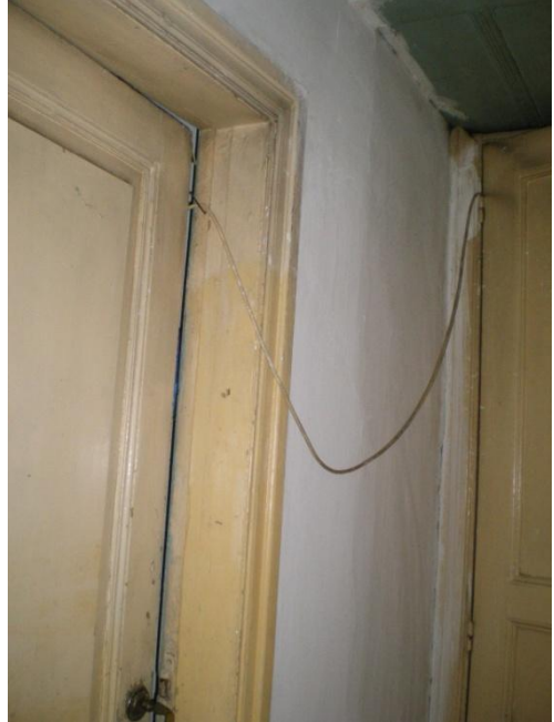
Resim 4.30-1. Hol – Z09 mekânı D1, D4 duvarı yönüne bakış
