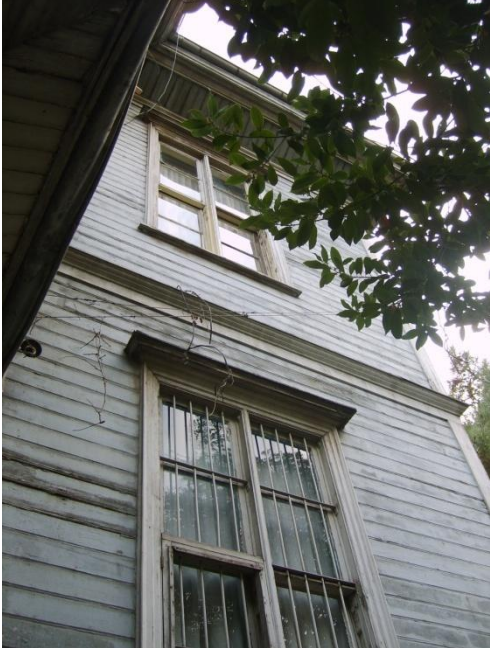
Resim 4.7-5. Kuzeybatı cephesi (C görünüşü) – D11 duvarı, P2-18 penceresi
