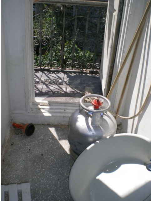
Resim 4.53-3. Banyo – 105 mekânı D1 duvarı K9-2 kapısı yönüne bakış
