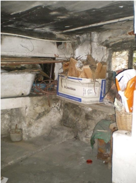
Resim 4.102-1. Odunluk – B08 mekânı D1 duvar yönüne bakış
