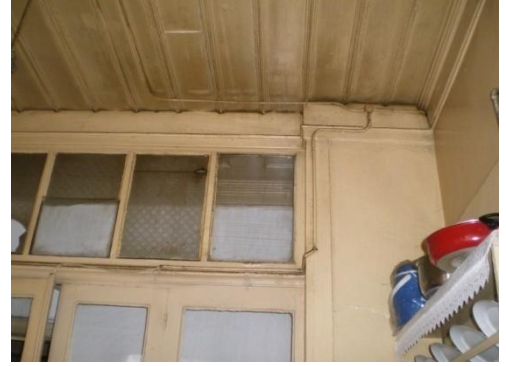
Resim 4.40-2. Mutfak – Z13 mekânı D3 duvarı K10 kapısı yönüne bakış
