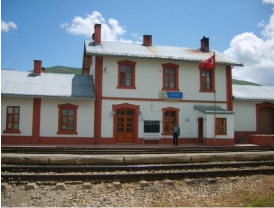
Resim 5.26. Yıldızeli İstasyonu gar ve lojman binası dış görünümü (2011)
