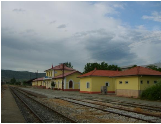
Resim 5.13. Turhal İstasyon alanı görünüşü (2011)
