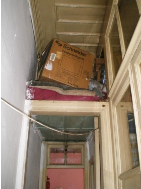
Resim 4.27-4. Hol – Z08 mekânı D4 duvarı K4-3 kapısı yönüne bakış
