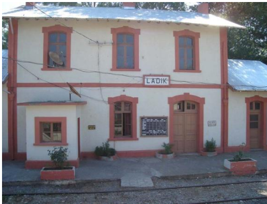
Resim 5.1. Ladik İstasyonu gar ve lojman binası dış görünümü
