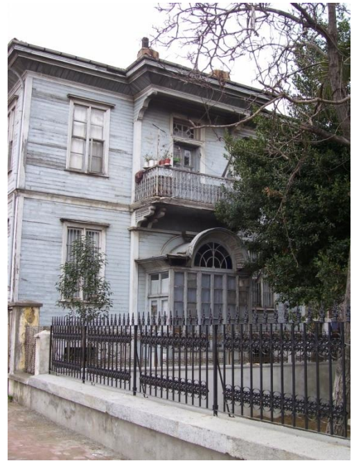
Resim 4.9-4. Kuzeybatı cephesi (C görünüşü) – genel görünüm
