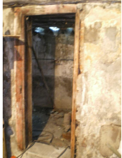
Resim 4.96-2. Odunluk – B06 mekânı D3 duvarı K14-2 kapısı yönüne bakış
