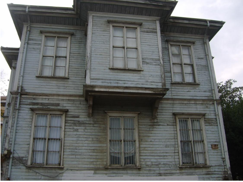
Resim 4.2-1. Kuzeydoğu cephesi (A görünüşü) – genel görünüm
