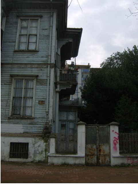
Resim 4.1-1. Kuzeydoğu cephesi (A görünüşü) – genel görünüm
