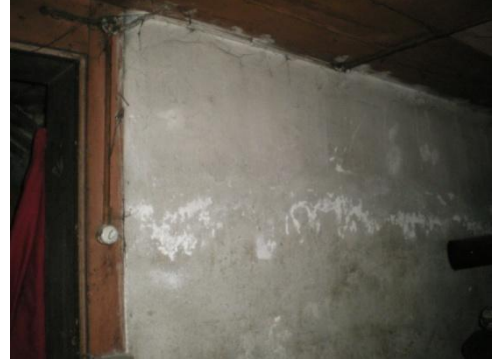
Resim 4.80-1. Odunluk – B02 mekânı D1 duvar yönüne bakış
