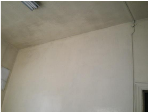
Resim 4.61-2. Oda – 107 mekânı D3 duvar yönüne bakış
