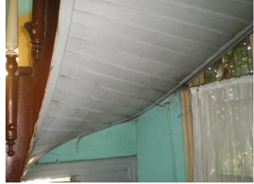
Resim 4.24-4. Giriş – Z07 mekânı D5, D6 duvar yönüne bakış
