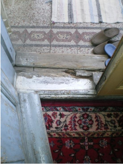
Resim 4.63-4. Oda – 108 mekânı oda – balkon döşeme yönüne bakış
