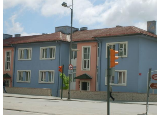
Resim 5.36. Sivas İstasyonu lojman binaları dış görünümü (2011)
