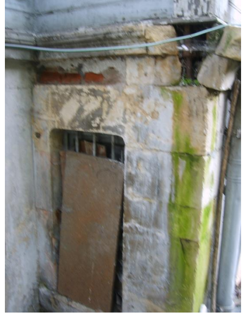
Resim 4.6-2. Kuzeybatı cephesi (C görünüşü) – D4 duvarı P6 penceresi
