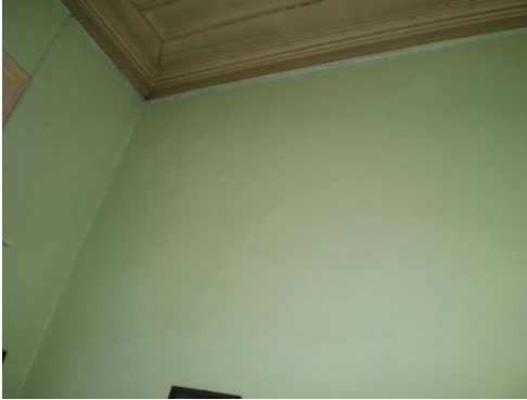
Resim 4.64-1. Oda – 108 mekânı D3 duvar yönüne bakış
