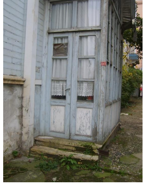
Resim 4.9-2. Kuzeydoğu cephesi (A görünüşü) – D4 duvarı K1-2 kapısı
