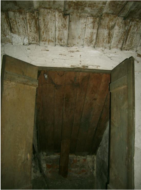
Resim 4.78-5. Odunluk – B10 mekânı D2, D3 duvarı, P8 penceresi yönüne bakış
