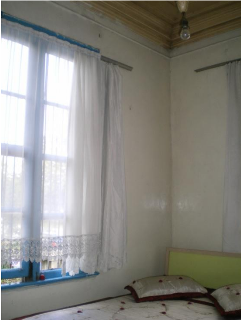
Resim 4.12-2. Oda – Z04 mekânı D2, D3 duvar yönüne bakış
