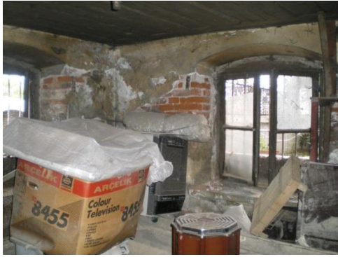
Resim 4.87-1. Odunluk – B03 mekânı D4 duvar yönüne bakış
