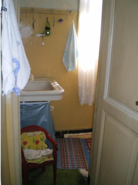
Resim 4.49-2. Hol – 102 mekânı D4 duvarı K7-2 kapı yönüne bakış
