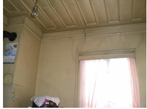
Resim 4.38-2. Mutfak – Z13 mekânı D1 duvar yönüne bakış
