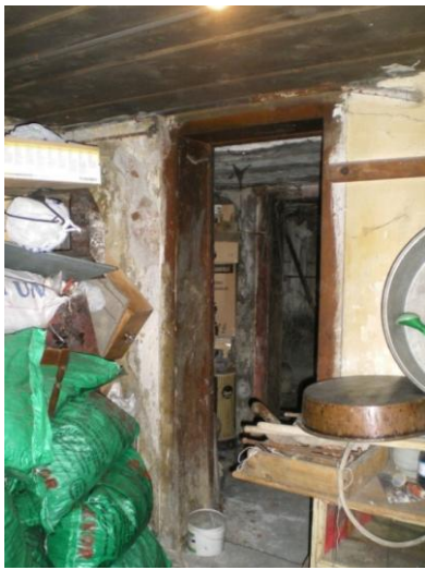
Resim 4.88-1. Hol – B04 mekânı D1 duvarı K15-2 kapısı yönüne bakış
