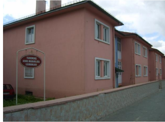
Resim 5.38. Sivas İstasyonu lojman binaları dış görünümü (2011)
