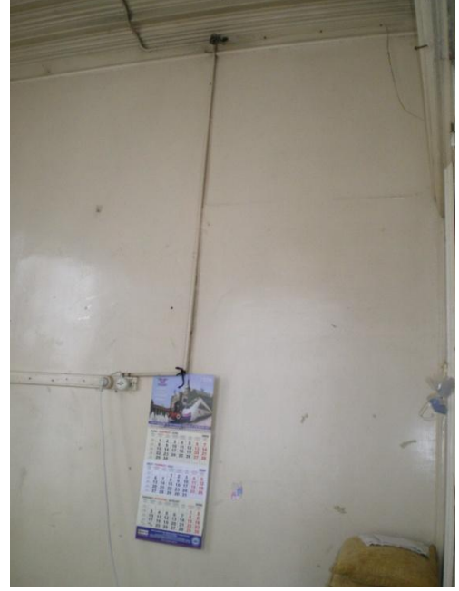
Resim 4.21-2. Oda – Z06 mekânı D1 duvar yönüne bakış
