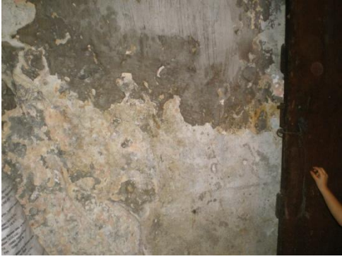
Resim 4.97-2. Odunluk – B06 mekânı D2 duvar yönüne bakış
