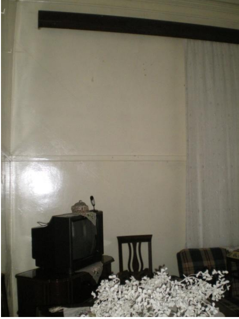
Resim 4.42-1. Oda – Z14 mekânı D1 duvar yönüne bakış
