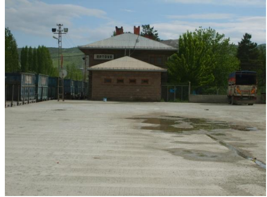
Resim 5.20. Artova İstasyonu gar ve lojman binası dış görünümü
