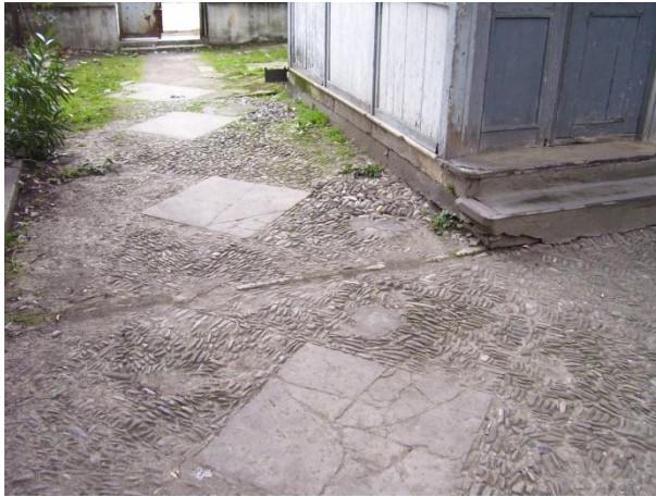
Resim 4.7-4. Kuzeybatı cephesi (C görünüşü) – rüzgarlık genel görünüm, yan bahçe zemini
