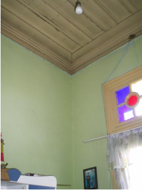
Resim 4.62-1. Oda – 108 mekânı D1, D2 duvar yönüne bakış
