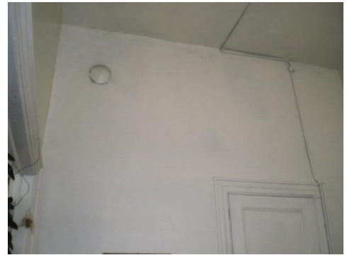
Resim 4.72-1. Oda – 111 mekânı D1 duvar yönüne bakış
