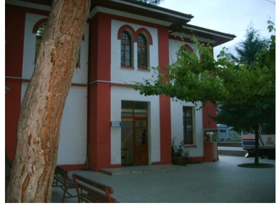
Resim 5.12. Amasya İstasyonu lojman binası görünümü
