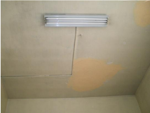
Resim 4.59-2. Oda – 107 mekânı tavan yönüne bakış
