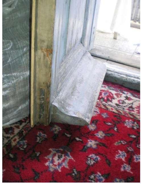
Resim 4.63-5. Oda – 108 mekânı D2 duvarı K11 kapısı yönüne bakış
