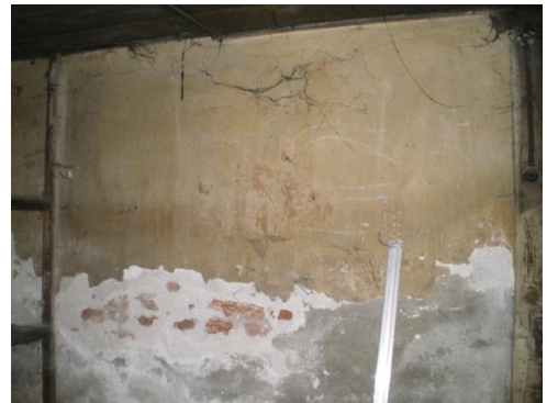
Resim 4.84-4. Odunluk – B03 mekânı D1 duvar yönüne bakış
