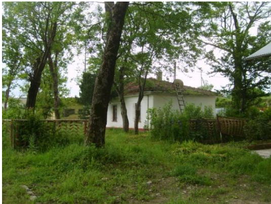
Resim 5.3. Ladik İstasyonu lojman binası dış görünümü
