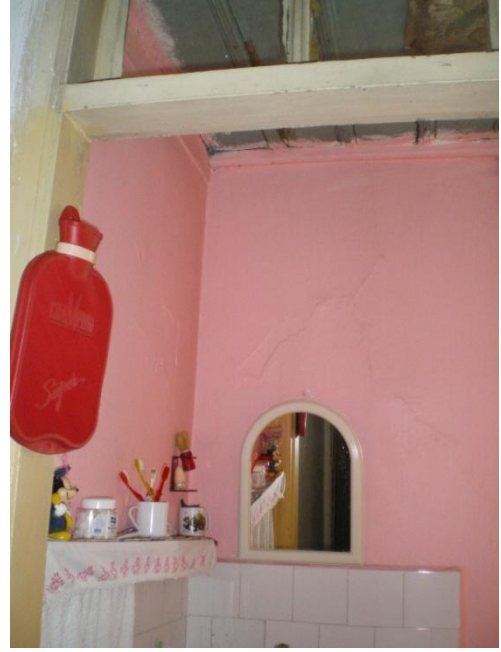
Resim 4.31-1. Lavabo – Z10 mekânı D3, D4 duvarı yönüne bakış
