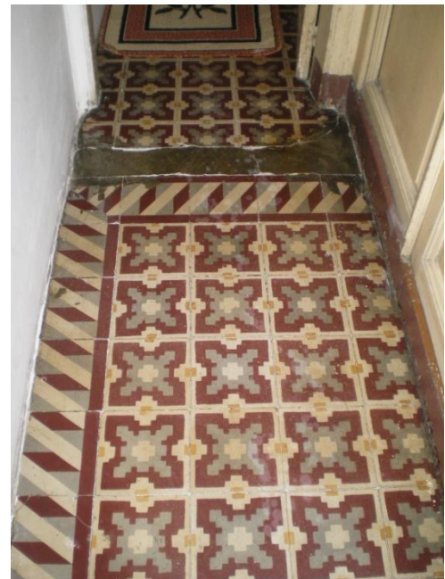
Resim 4.27-1. Hol – Z08 mekânı döşeme yönüne bakış
