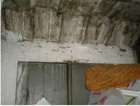
Resim 4.78-3. Hol – B01 mekânı D2 duvarı, P8 penceresi yönüne bakış
