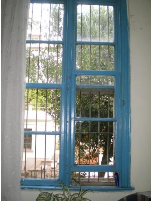
Resim 4.43-1. Oda – Z14 mekânı D2 duvarı P2-9 penceresi yönüne bakış
