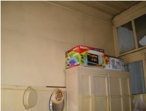
Resim 4.39-3. Mutfak – Z13 mekânı D2 duvar yönüne bakış
