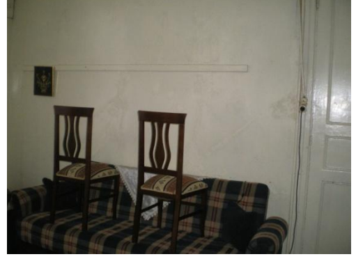
Resim 4.44-3. Oda – Z14 mekânı D3 duvar yönüne bakış
