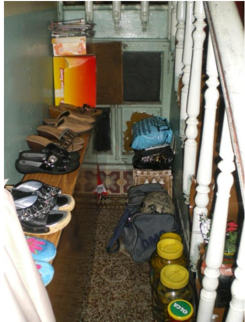
Resim 4.4-2. Giriş – Z02 mekânı D3, D4 duvar yönlerine bakış
