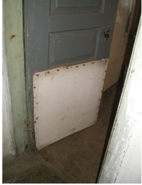
Resim 4.106-1. Odunluk – B08 mekânı D6 duvarı K4-14 kapısı yönüne bakış
