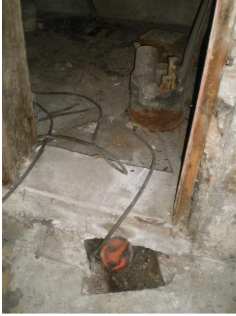
Resim 4.96-3. Odunluk – B06 mekânı D3 duvarı K14-2 kapısı yönüne bakış
