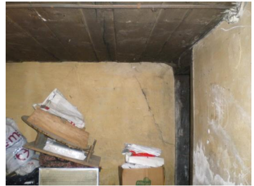
Resim 4.89-1. Hol – B04 mekânı D2, D3 duvar yönüne bakış
