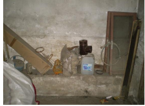
Resim 4.83-2. Odunluk – B02 mekânı D4 duvar yönüne bakış
