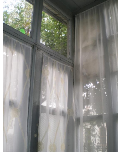
Resim 4.2-1. Rüzgarlık – Z01 mekânı D1 duvar yönüne bakış
