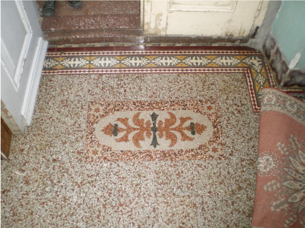
Resim 4.7-2. Giriş – Z02 mekânı döşemeye bakış
