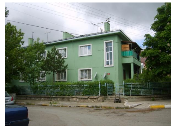
Resim 5.40. Sivas İstasyonu lojman binaları dış görünümü (2011)
