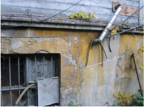
Resim 4.6-7. Güneybatı cephesi (B görünüşü) – Bodrum kat
