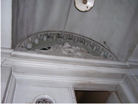
Resim 4.2-4. Rüzarlık – Z01 mekânı D4 duvar yönüne bakış
