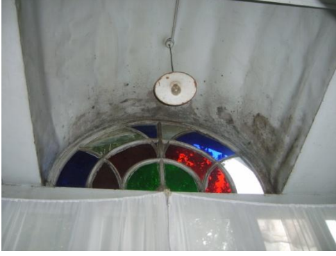
Resim 4.1-1. Rüzgarlık – Z01 mekânı D2 duvar yönüne bakış
