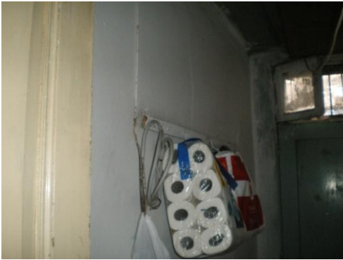
Resim 4.35-4. Kiler – Z12 mekânı D4 duvar yönüne bakış
