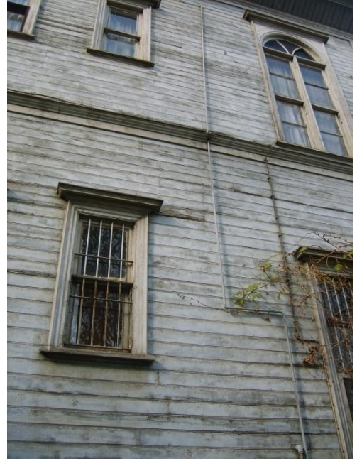
Resim 4.4-2. Güneydoğu cephesi (D görünüşü) – genel görünüm
