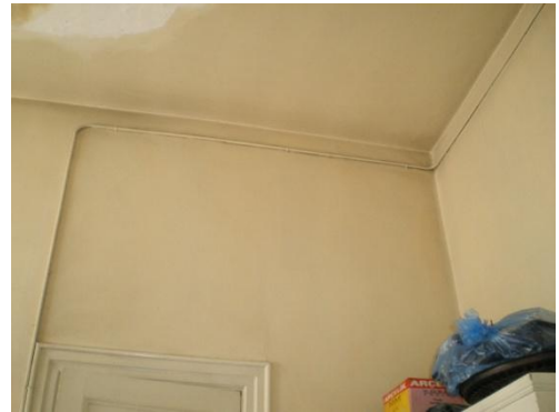
Resim 4.56-5. Mutfak – 106 mekânı D2 duvar yönüne bakış
