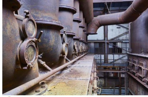
10 KURU GAZ ARITMA TESİSİ II
