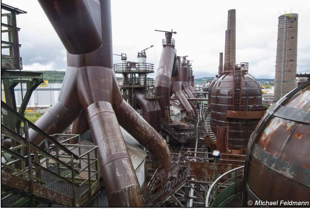
Fotoğraf 79. Völklingen Demir İşletmesi yüksek fırınlar ve açılı üst gaz boruları (fotoğraf: Michael Feldmann)
