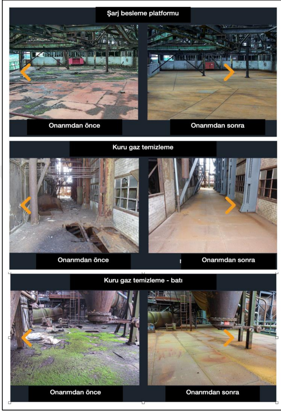
Fotoğraf 60. Völklingen Demir İşletmesi yürüme parkurlarının ve tehlike önleme çalışmaları
