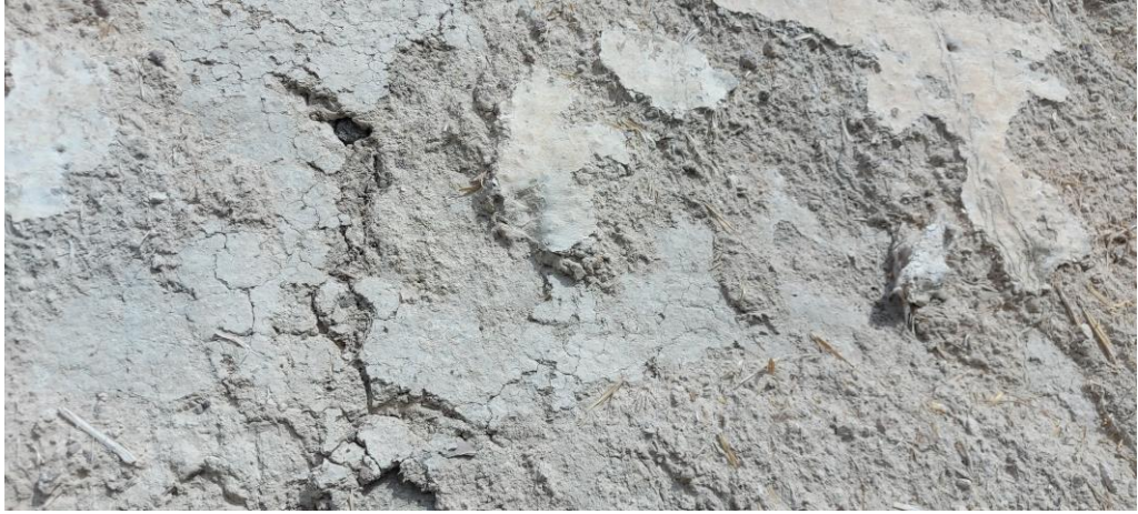
Şekil 57. Tekdamlar Mahallesi Malakan evi kalıntısı duvar iç yüzeyi saman katkılı sıva
