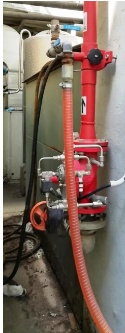
Şekil 2.42. Köpük hattı için yanlış bir uygulama görseli
