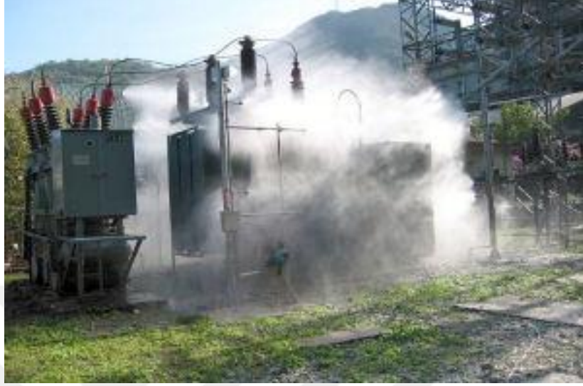
Şekil 2.9. Su sisi sistemine ait görsel
