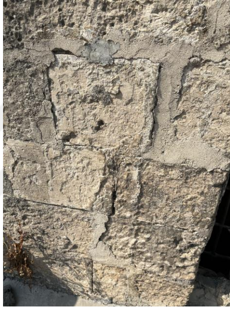
Şekil 3.43 Çimento esaslı onarım
