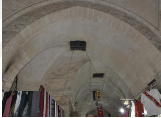
Şekil 3.48 Tonozda niteliksiz sıva uygulaması
