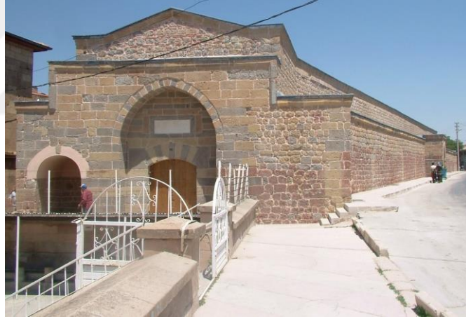
Şekil 2.72 Restorasyon sonrası (VGM Arşiv)
