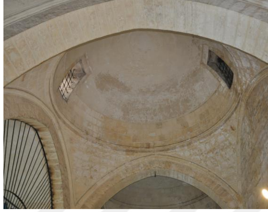
Şekil 3.47 Kubbelerde niteliksiz sıva uygulaması
