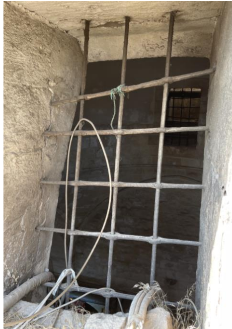
Şekil 3.66 Deforme olmuş parmaklık
