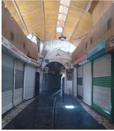
Şekil 3.10 Güney cepheyi çevreleyen dükkânlar
