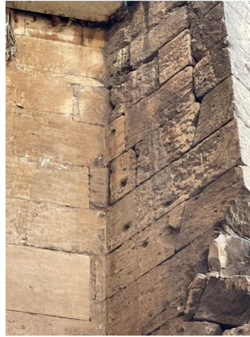
Şekil 3.101 Düzensiz birleşim görseli
