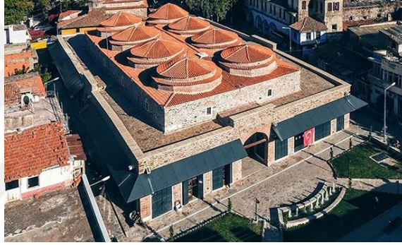
Şekil 2.58 Restorasyon sonrası (URL-4)
