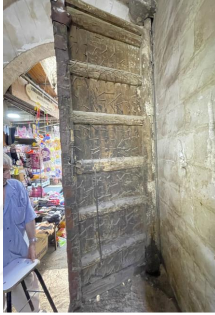
Şekil 3.63 Kapıda yıpranma
