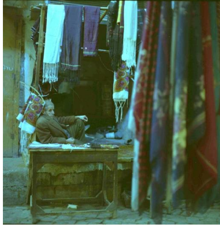
Şekil 3.92 1998 onarım öncesi görsel (Kürkçüoğlu, C)
