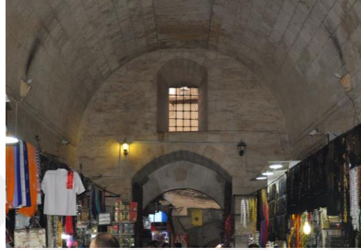
Şekil 3.59 Aydınlatmanın olduğu bölümde islenme
