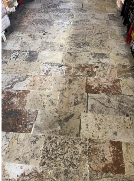
Şekil 3.41 Çimento esaslı derz
