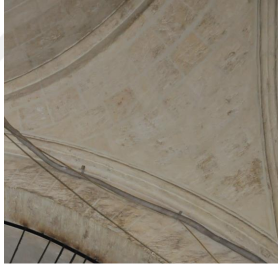
Şekil 3.46 İç cephe çimento esaslı derz uygulaması
