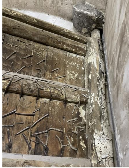
Şekil 3.64 Üst ökçede aşınma
