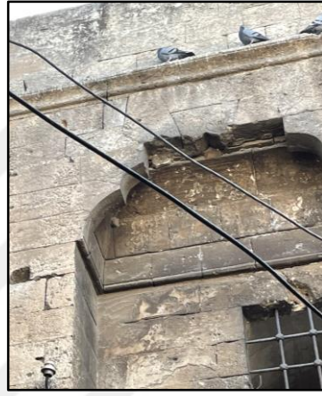
Şekil 3.8 Sarkıt süslemenin kopan bölümü
