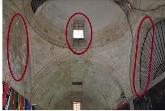
Şekil 3.60 Kaynak izleri ve su sızıntısına bağlı kirlenme
