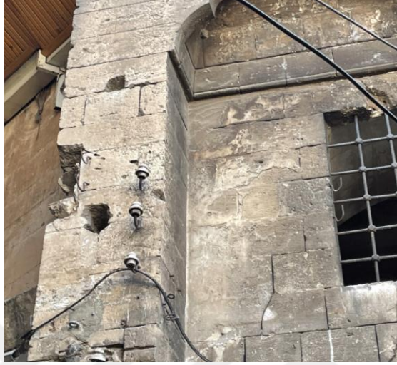
Şekil 3.45 Doğu cephesi çimento esaslı derz uygulaması
