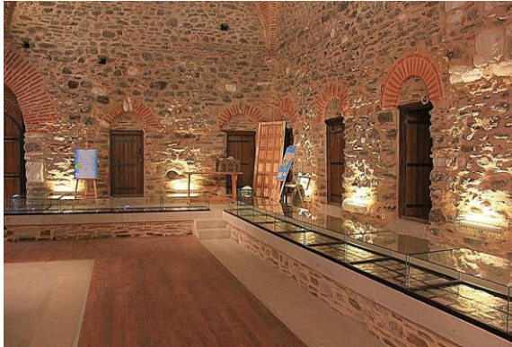
Şekil 2.59 Restorasyon sonrası (URL-5)
