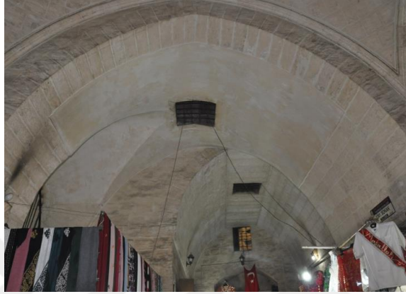
Şekil 3.105 Geçiş kısmına ait tonoz birleşim görseli
