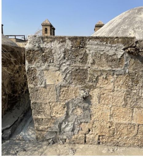
Şekil 3.55 Kubbe kaidelerinde aşınma ve ayrılmalar
