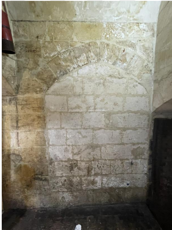
Şekil 3.34 Kapatılmış kemer açıklığı
