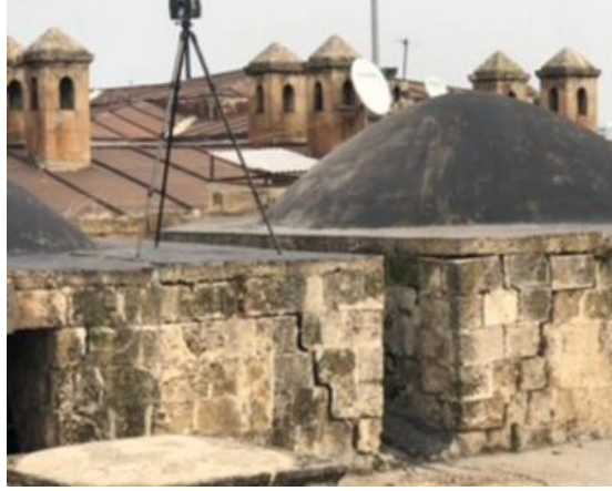
Şekil 3.52 Kubbe kaidesinde derz boşalması ve ayrılmalar
