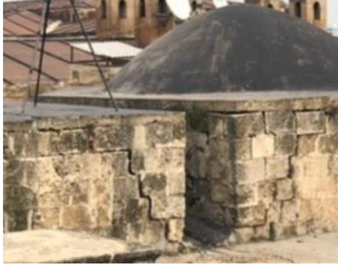
Şekil 3.70 Kubbe kaidelerinde statik açıdan ayrılma ve bozulmalar
