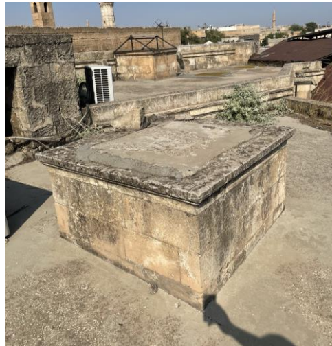
Şekil 3.39 Kapatılmış tepe pencere
