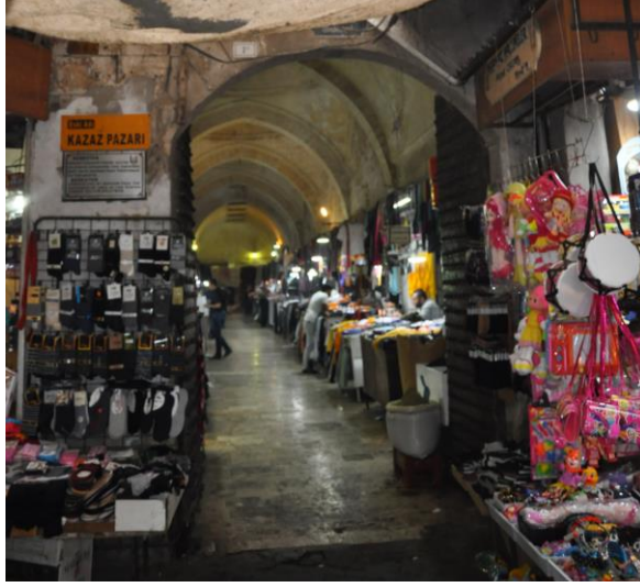
Şekil 3.33Yapının traverten döşemeli mevcut hali
