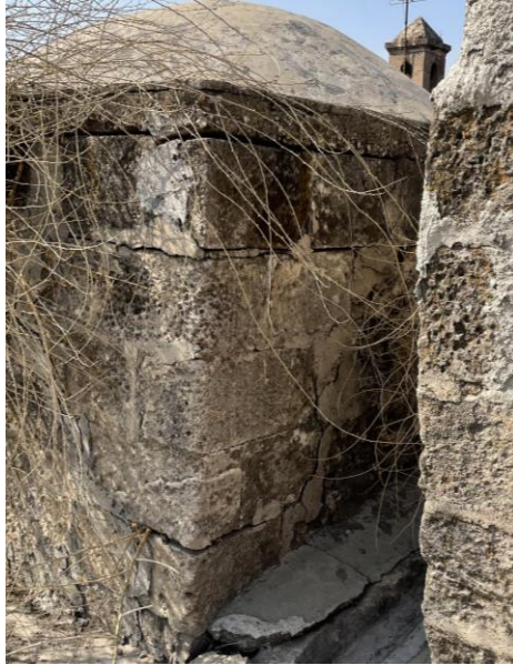
Şekil 3.56 Kubbe kaidelerinde ayrılmalar
