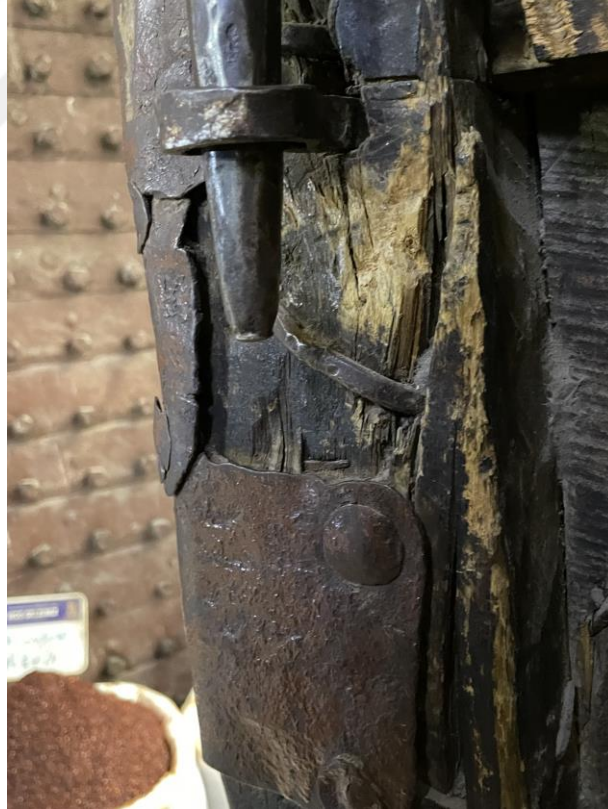
Şekil 3.68 Dövme demir kaplama
