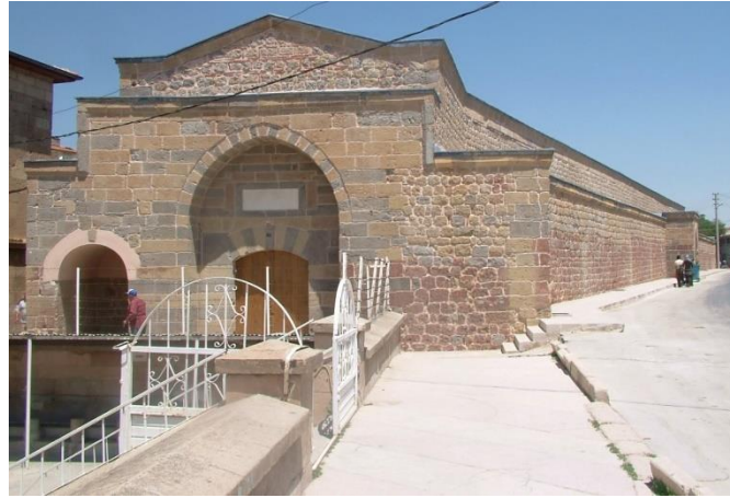
Şekil 3.81 Restorasyon sonrası (VGM Arşiv)
