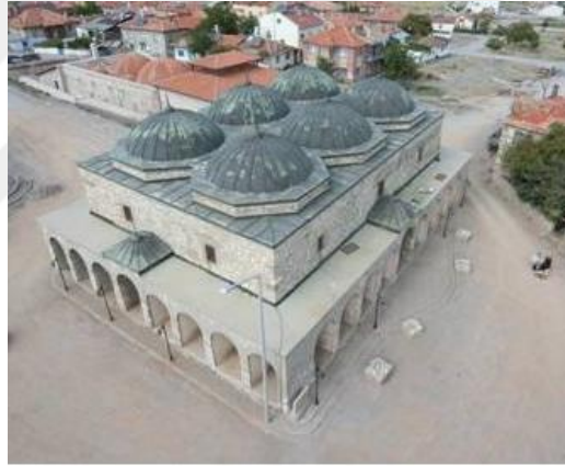
Şekil 2.68 Restorasyon sonrası (VGM Arşiv)
