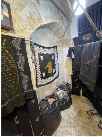
Şekil 3.35 Kapatılmış kemer açıklığı
