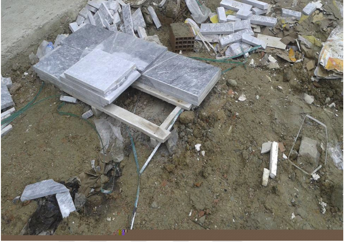
Şekil 7.3. Özensiz işçilik ile zarar gören kaplama malzemeleri (Balaban, 2014).
