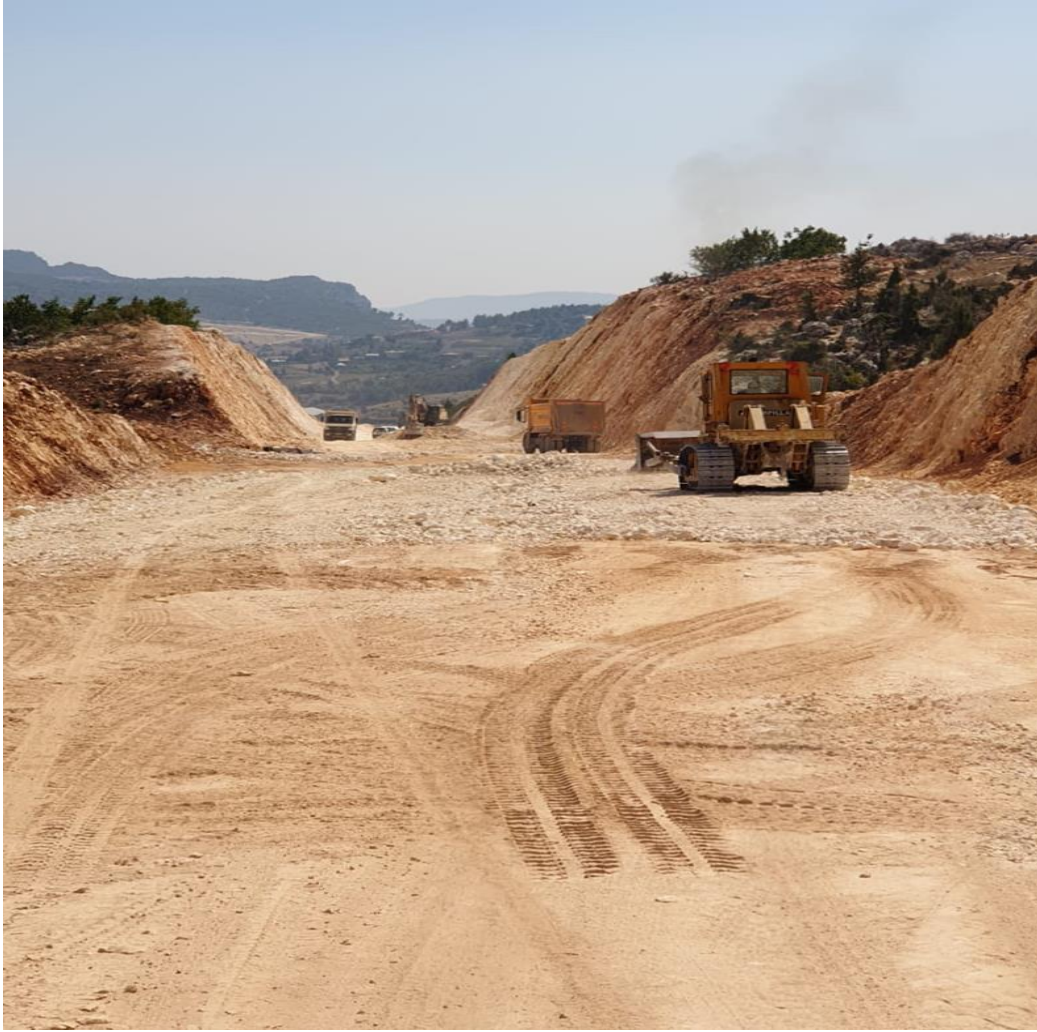
Şekil 4.6. Tarsus-Çamlıyayla ana karayolunda devam eden yol yapım çalışmalarından bir görünüm
