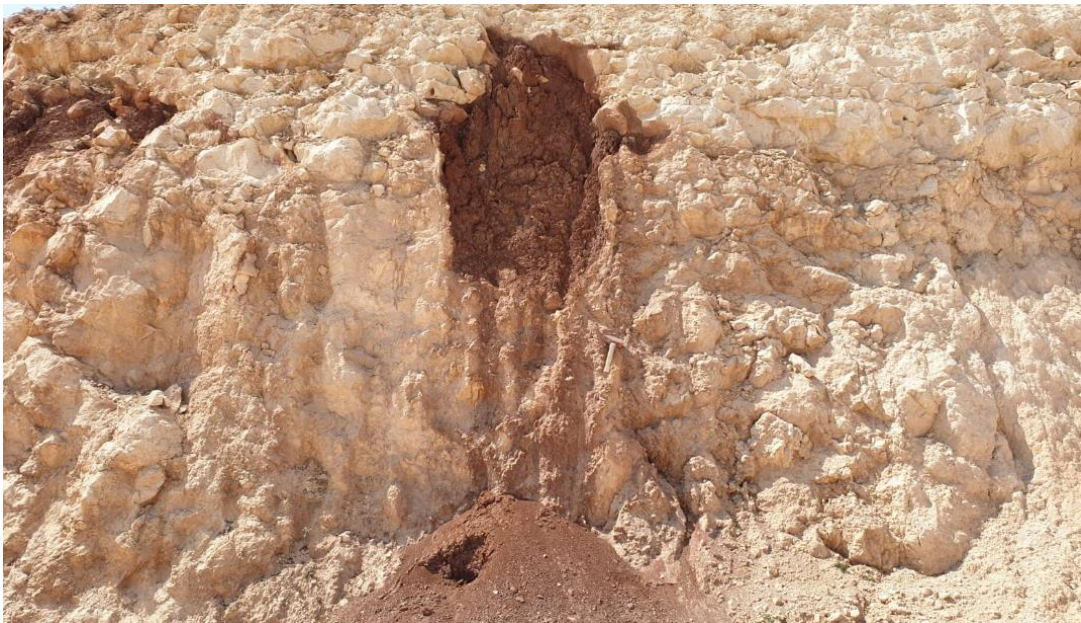
Şekil 4.15. Karaisalı kireçtaşları içerisinde yol yarmasında ortaya çıkan ve yan kayaçları ile keskin dokanak ilişkisi sunan gevşek toprağımsı Terra Rossa çökellerinin taşınarak bu karst kanallarında çökelmiş olduğu anlaşılmaktadır. Çünkü etrafında herhangi bir ayrışma emaresi gözlenmemektedir
