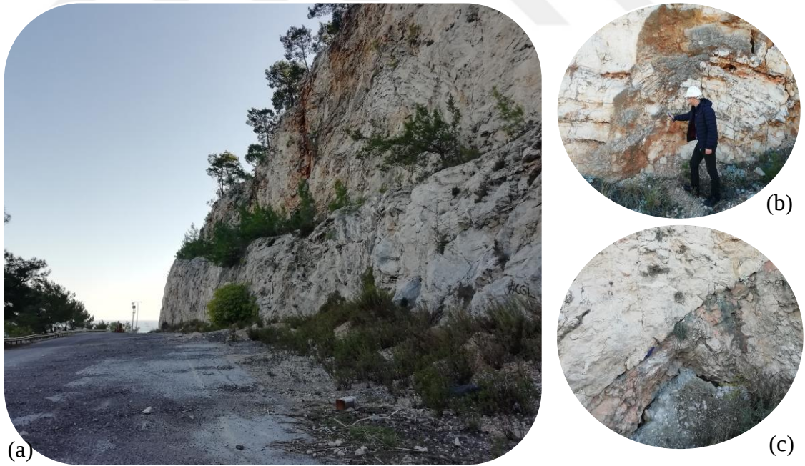
Şekil 4.13. a) 4 nolu lokasyonda 11 nolu şeve ait genel görünüm; b) ve c) de çatlakların detaylı görünümü
