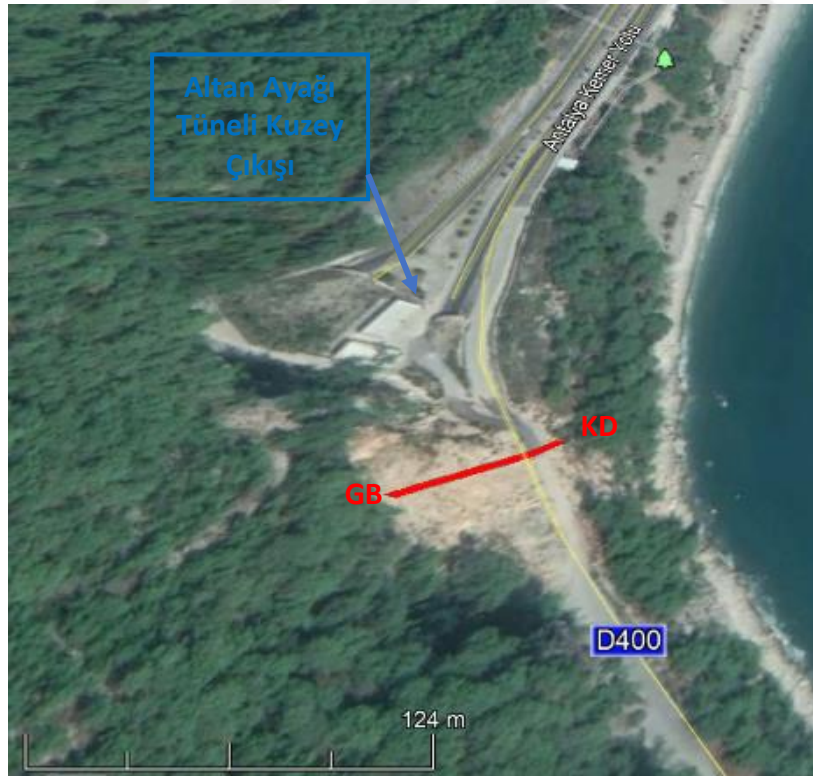
Şekil 4.3.21. Heyelanın geliştiği 12 nolu şev yüzeyinde (normal fay düzlemi) düzlemsel kayma şeklinde gelişen duraysızlığa ait harita görünümü ve GB-KD yönünde alınmış kesit hattı
