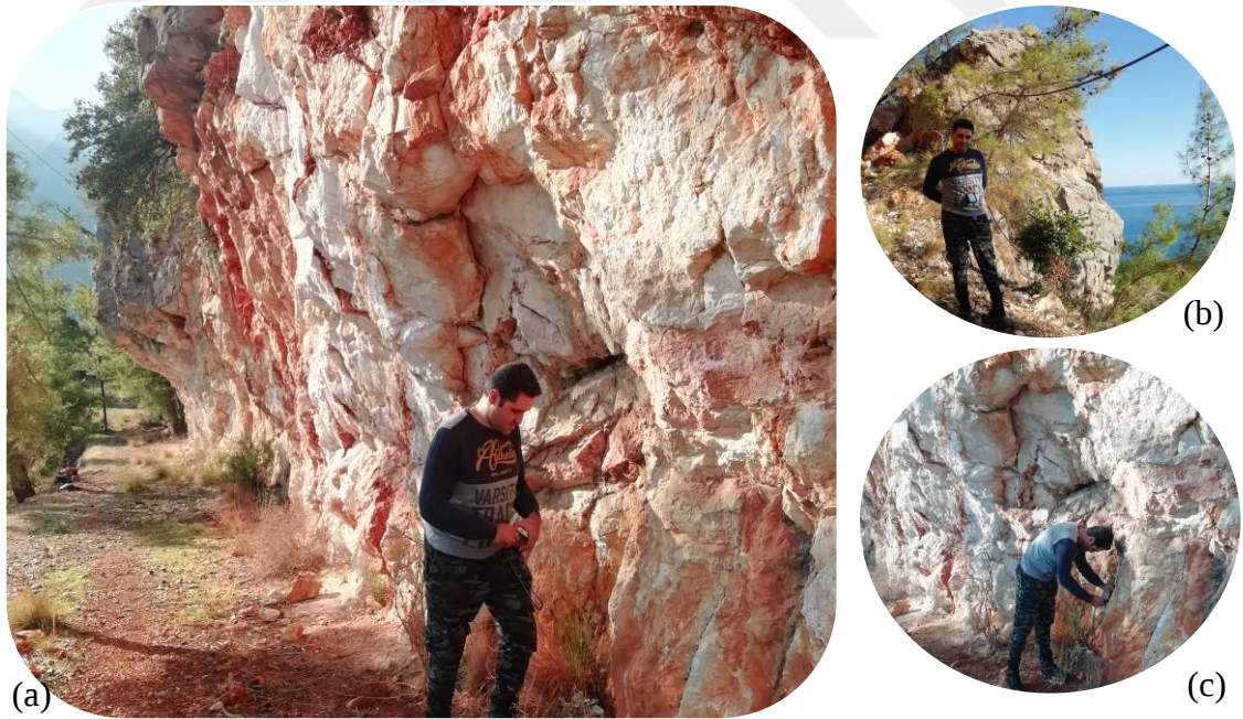
Şekil 4.11. a) 4 nolu lokasyonda 9 nolu şeve ait genel görünüm; b) kopan bloğun ve c) çatlak yüzeyi ölçümünün detaylı görünümü
