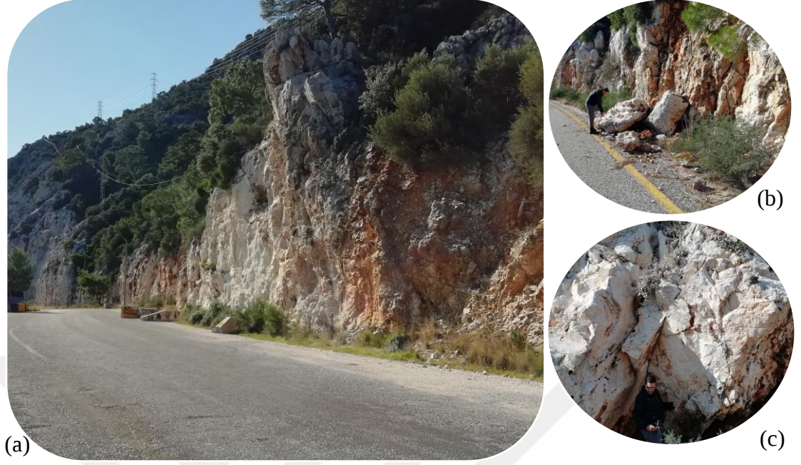
Şekil 4.6. a) 2 nolu lokasyonda 4 nolu şeve ait genel görünüm; b) Şev önünde meydana gelmiş kaya blokları; c) çatlakların detaylı görünümü
