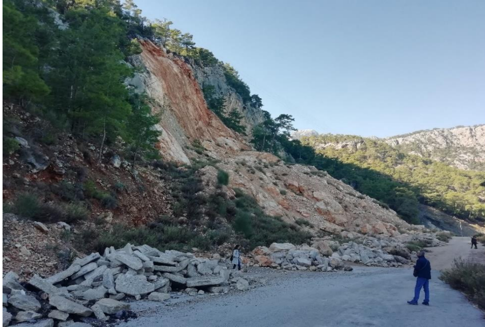
Şekil 4.3.23. 4 nolu lokasyonda 12 nolu şev yüzeyinde gelişmiş heyelandan bir görünüm
