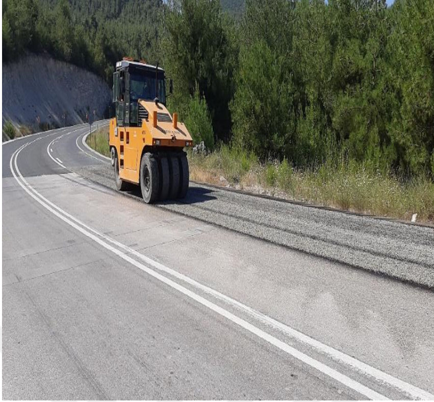
Şekil 2.6. Lastik Tekerlekli Silindir
