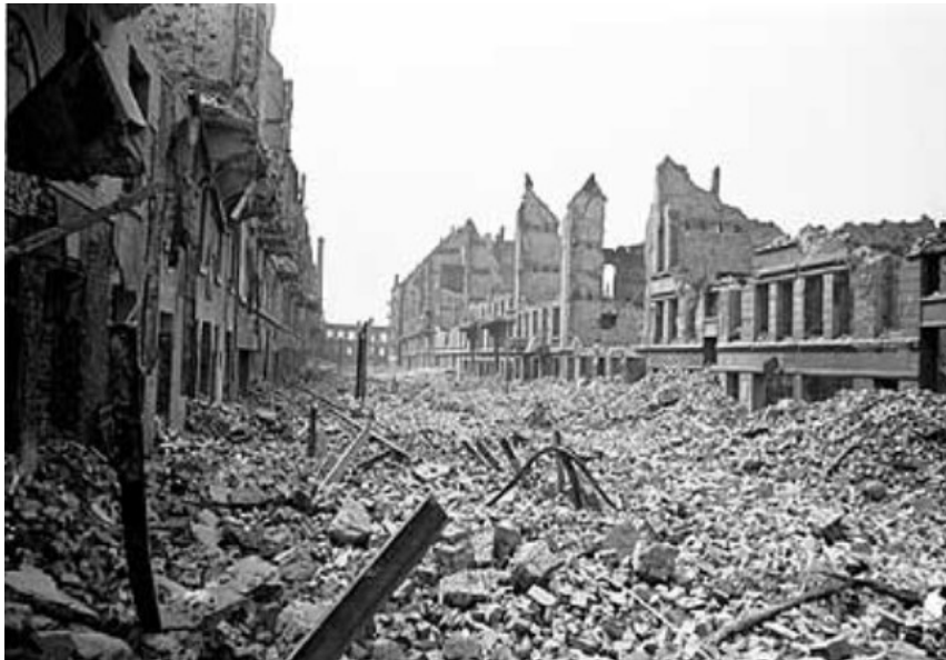
Bild 3: Die Straße Kreuzbrook in Hamburg-Hamm ( Quelle: http://www.geo.de/GEO/fotografie/fotogalerien/1412.html?t=img&p=7 )
