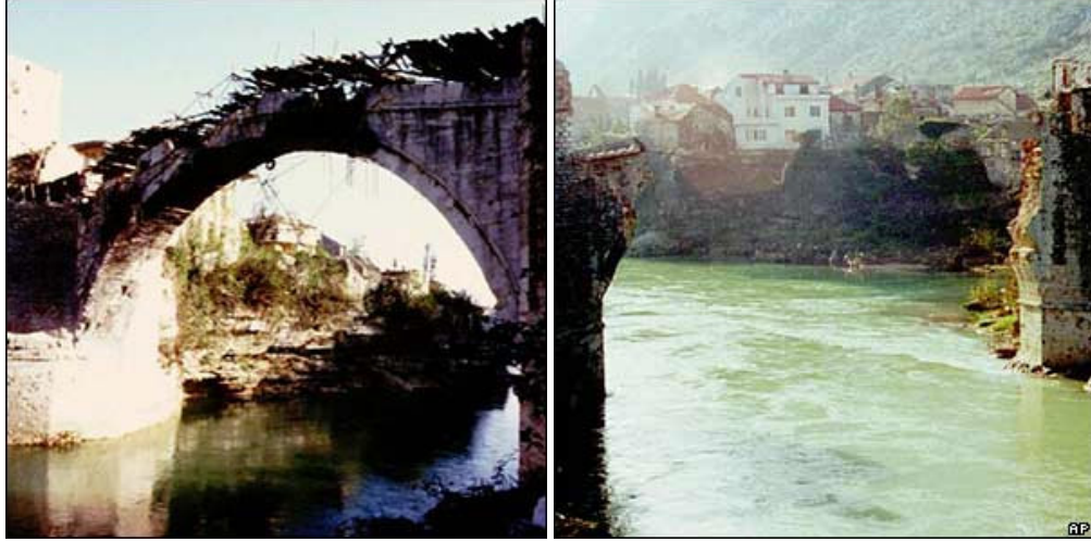
Resim 10. Köprüye ilk saldırıyı 1992’de Bosnalı Sırlar düzenledi. Kasım 1993’te Hırvat tankları köprüye daha büyük bir zarar veren saldırılarını başlattı. Kasım ayının sonunda köprü tamamen yıkıldı. Dev taşları, Neretva’nın sularına gömüldü. Köprünün yıkımı, Mostar’ın çok uluslu mirasının reddedilmesinin simgesi olarak görüldü.
