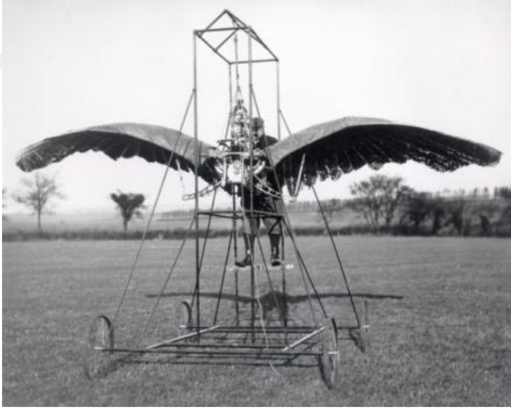
Şekil 2.8. Edward P. Frost’un içten yanmalı motorla tahrik ettiği ornithopter tasarımı (Anonymous 7 2023)
