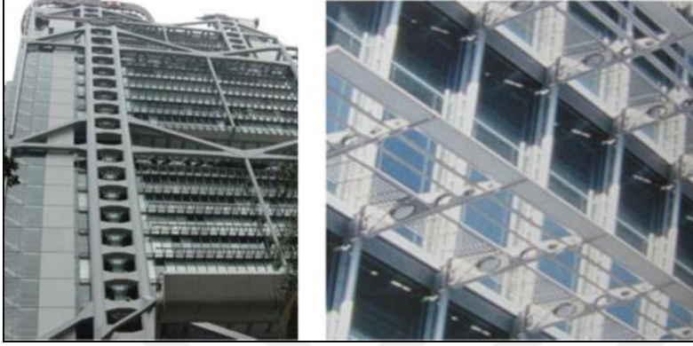
Resim 2.2. Hong Kong ve Shanghai bankası güneş kontrol elemanları [19]
