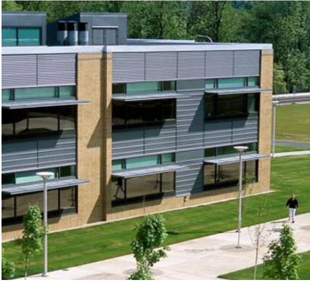
Resim 2.16. Clackamas high school binasında ışık raflarının dış cephede görünümü [94]
