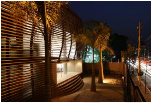
Resim 2.8. Loducca Agency binası yatay güneş kırıcı kullanımı [67]
