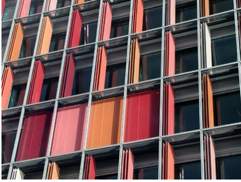
Resim 2.6. GSW Yönetim Binası [33].
