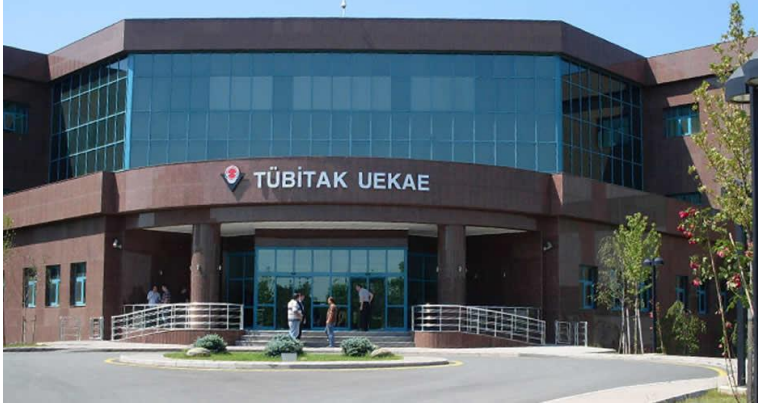
Resim 2.4. Tubitak Gebze binası entegre güneş kontrol elamanı kullanımı [21]
