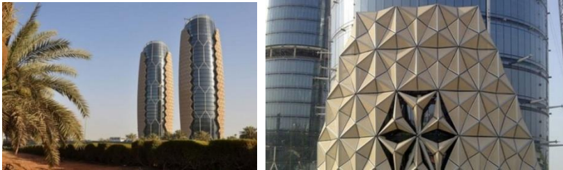
Resim 2.7. Al Bahar Towers binasının dıştan görünümü ve gölgeleme elemanı detayı [55]
