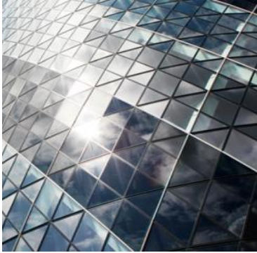
Resim 2.15. Swiss Re binası fotovoltaik cam görünümü [90]
