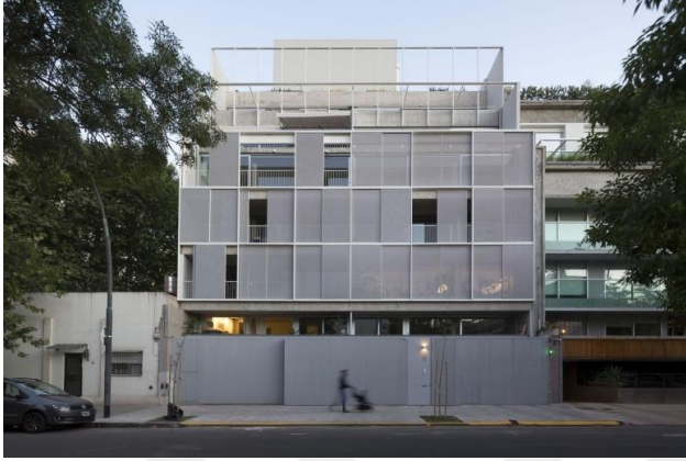
Resim 2.11. Housing Building Sucre 812 binası hareketli güneş kırıcı kullanımı [71].
