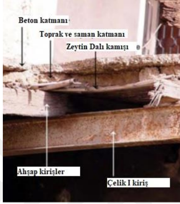
Şekil 46. Amman kırsal konutundaki çatı katmanları (Shawash, 2011)
