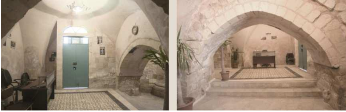
Şekil 66. Madafat Farah Abu Jaber diğer çapraz tonozlu odalara giden ana varil tonozlu galeri (Almatarneh, 2013)
