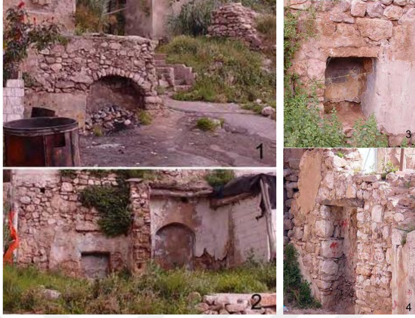
Şekil 47. Matwa tipleri: 1. Kemerli taş kirişi olan matwa, Jabal al-Qal'a Mahallesi 2. Üzeri hala sıva ile kaplı olan, biri kemerli taş kirişli diğeri düz olan iki matwa, Jabal al-Qal'a Mahallesi 3. Tek taş kirişli matwa, Mohajireen Mahallesi, 4. Ahşap kirişli matwa, Mohajireen Mahallesi (Shawash, 2011)
