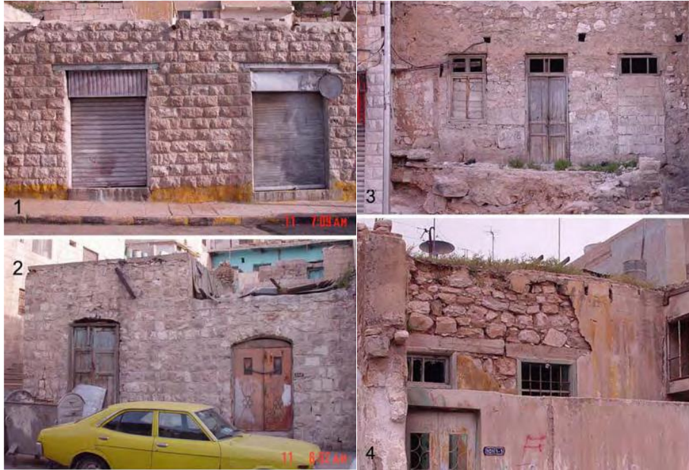
Şekil 48. Kiriş türleri ve taşın yapı inşasında nasıl kullanıldığı: 1. Mavi tonlu I kirişli Tobzeh taş cepheli, eski Amman mimarisinin karakteristik bir ögesi oluşturan bir bina, nispeten düzgün bir taş cepheli, Mohajireen Mahallesi, 2. Mohajireen Mahallesi'nde düzensiz taş sıraları ve taş kemer kirişleri, 3. Mohajireen Mahallesi'nde beton kirişlerle moloz duvar inşası, 4. Taş sıvalı, düzensiz taş cephe ve ahşap kirişler, Jabal al-Nadif (Shawash, 2011)
