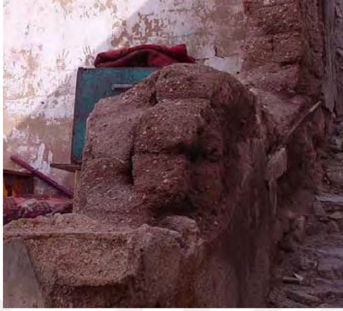
Şekil 34. İki katmanlı kerpiç tuğladan yapılmış duvar, Muhacirler Mahallesi (Shawash, 2011)
