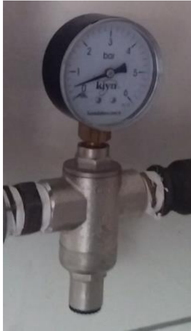
Şekil 4.22. Basınç düşürücü ve manometre.
