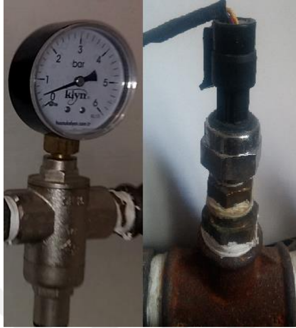
Şekil 8.3. Şebeke basınç düşürücü ve basınç sensörü bağlantısı.
