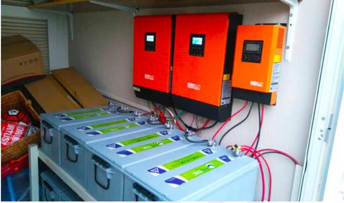
Resim 1.6 Solar akü ve kontrol birimleri.
