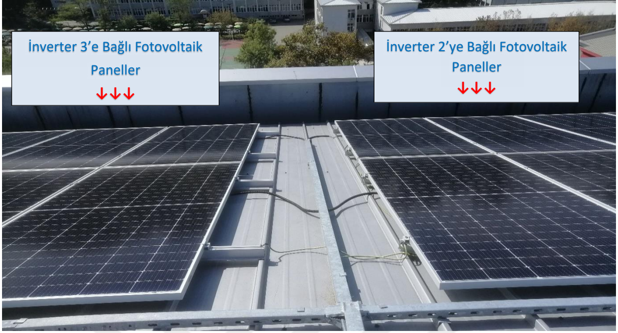
Şekil 4.3 İnverter 2 ve 3'e bağlı fotovoltaik panellerin temizlik uygulanmış ve doğal bırakılmış durumlarının karşılaştırmalı gösterimi.
