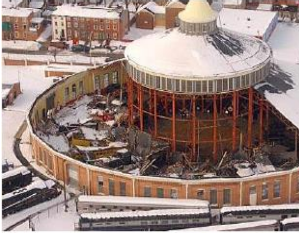
Şekil 2.8: Çöken müze binası çatı örneği.
