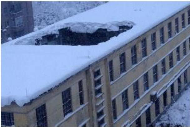
Şekil 2.9: Çöken fabrika çatı örneği.
