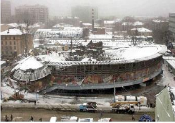
Şekil 2.7: Çöken kapalı pazaryeri çatı örneği.
