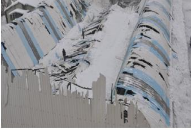
Şekil 2.10: Çöken halı saha çatı örneği.
