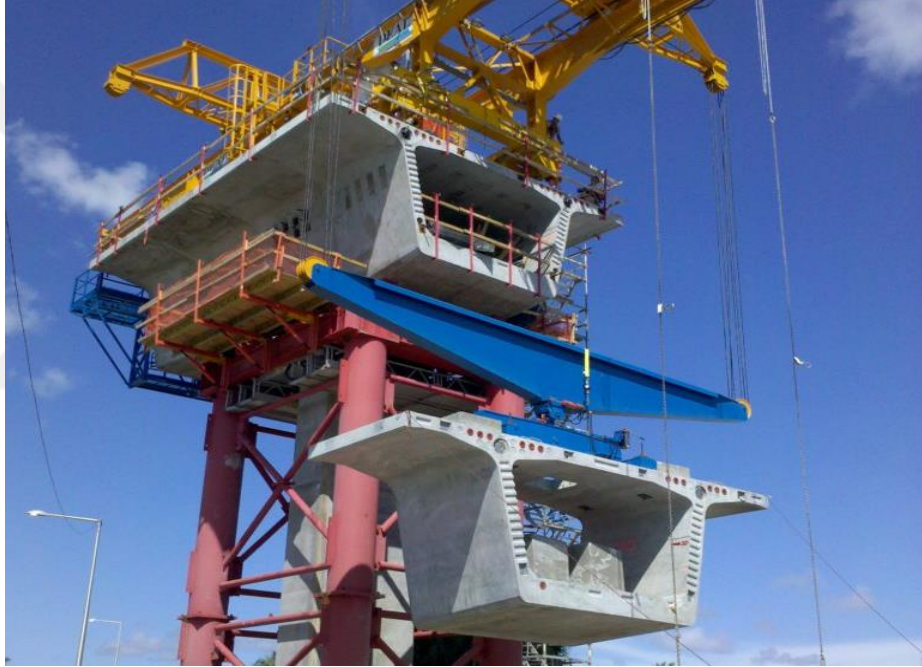
Şekil 3.32. Segmental prekast öngerilmeli beton konsol yöntemi yapımı [24].
