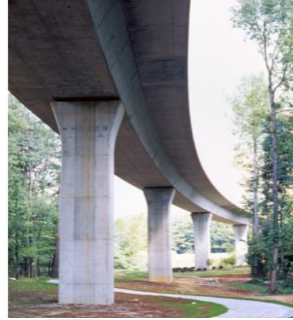
ekil 2.3. Yerinde gerilmiş sandık kiriřli kpr kiriřinin yerleřtirilmesi [1].
