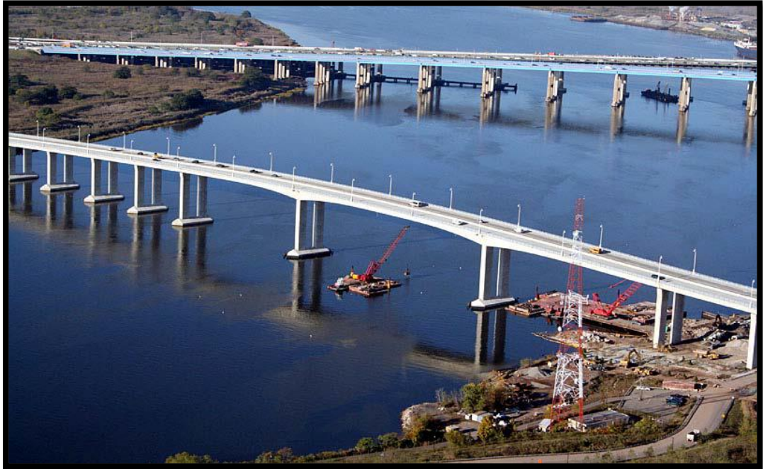
Şekil 1.2. Segmental öngerilmeli beton köprü [3].
