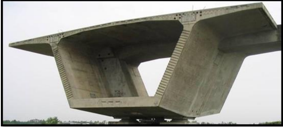
Şekil 3.31. Kutu kiriş köprü kesit görünümü [23].
