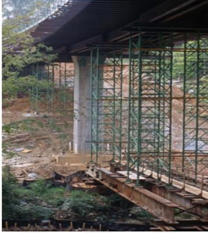
ekil 2.3. Yerinde gerilmiş sandık kiriřli kpr kiriřinin yerleřtirilmesi [1].
