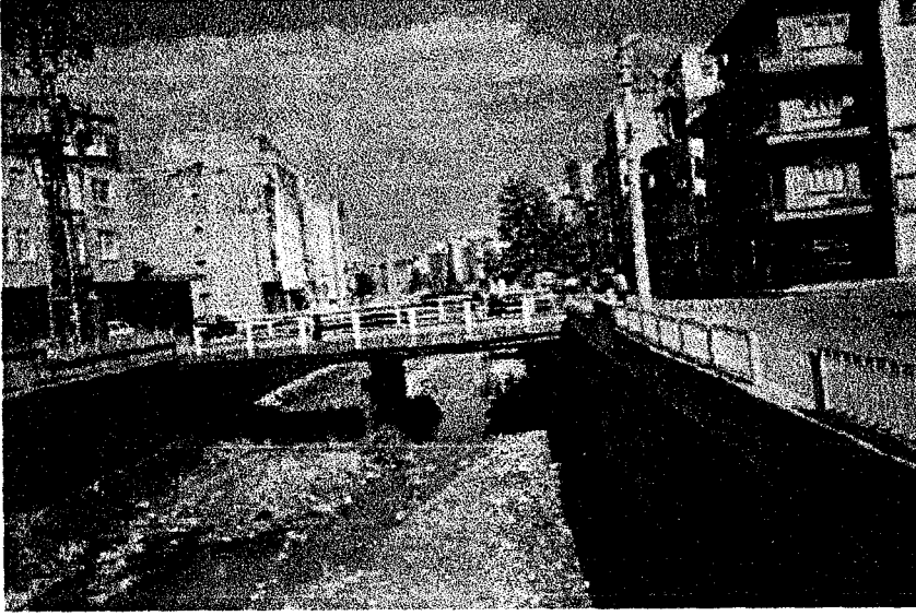
Foto 15 : Islah çalışması yapılan Bülbul Deresi'nden bir görünüm.
