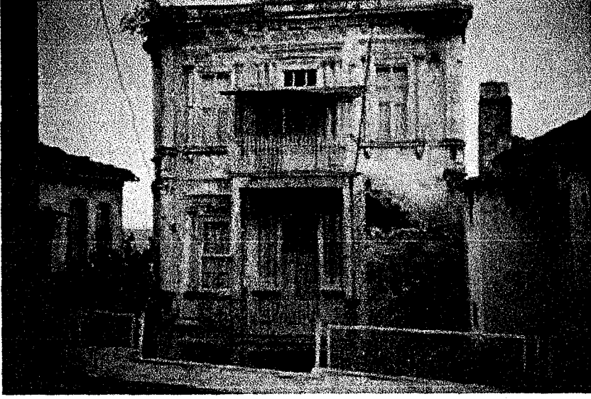
Foto 25 : Taşbaşı Mahallesi'nde yer alan eski bir taş bina.
