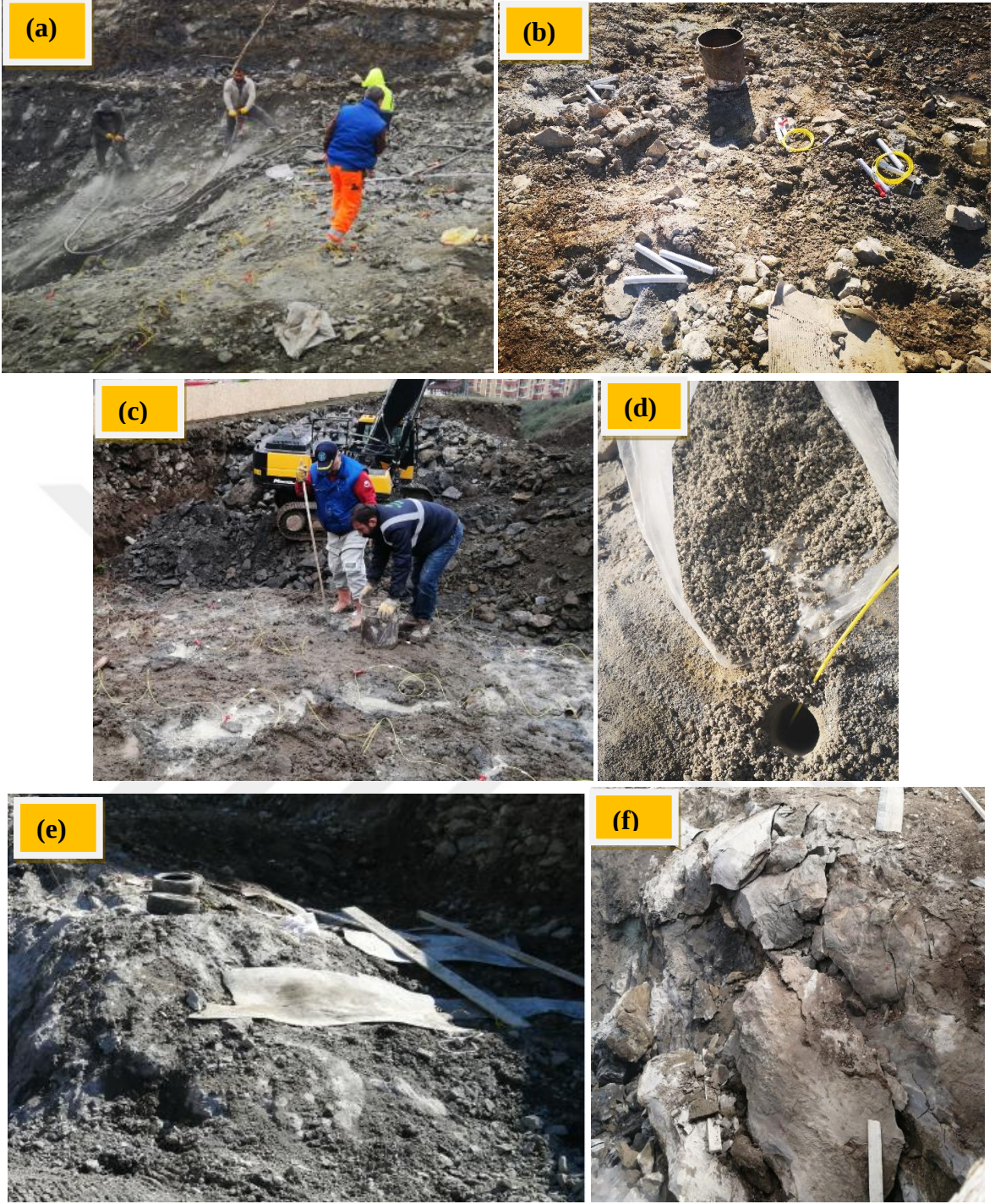
Şekil 12. (a) Patlatma deliklerinin açılması, (b) kullanılan patlayıcı maddeler ve NONEL kapsüller, (c, d) sıkılama işlemi, (e) deliklerin üzerinin membranla örtülmesi, (f) patlatma işlemi sonrası görünüm
