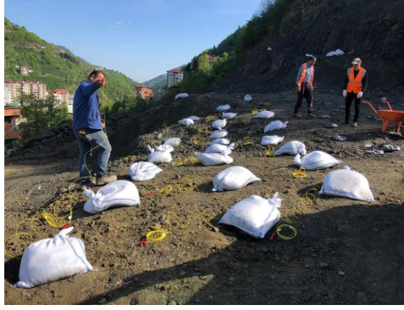
Şekil 4. Kaya fırlamasını engellemek için şarjlı deliklerin üzerinin örtülmesi
