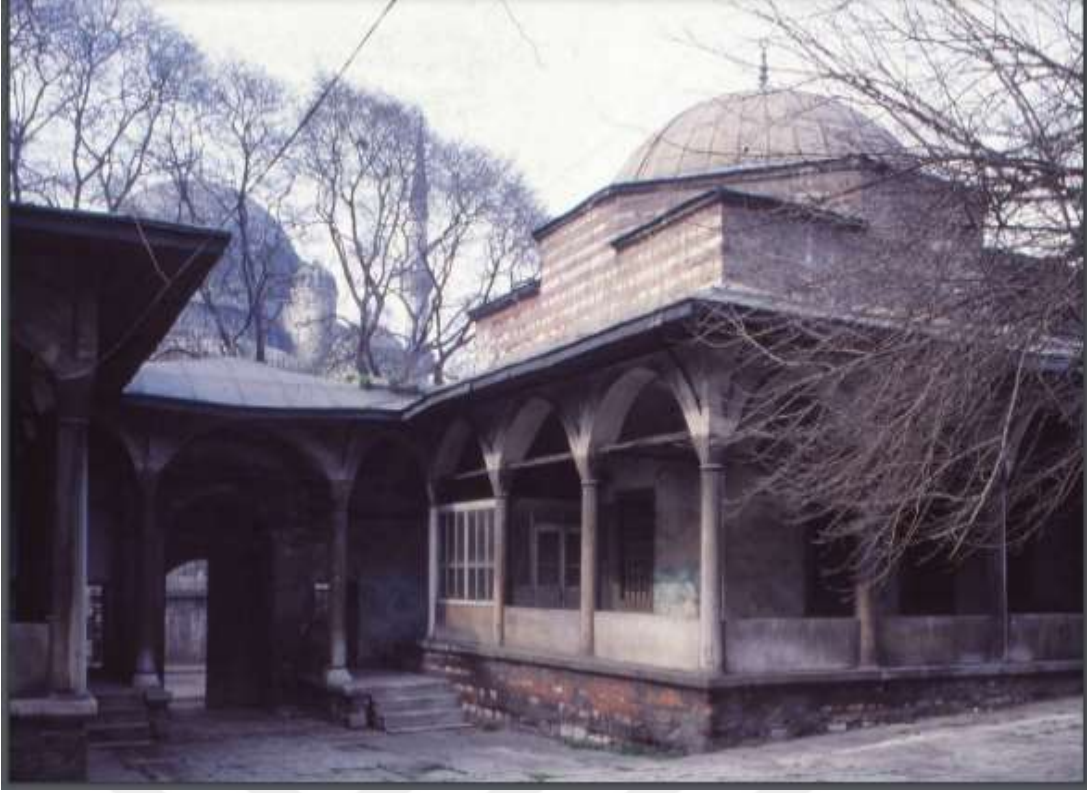
Şekil 5 İbrahim Paşa Kütüphanesi
