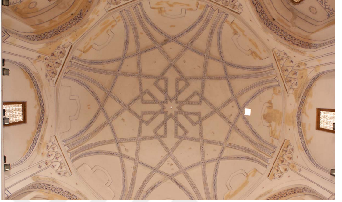
EK 11: Sultan Sencer Türbesi'nin Kubbesinin İç Görünümü.
