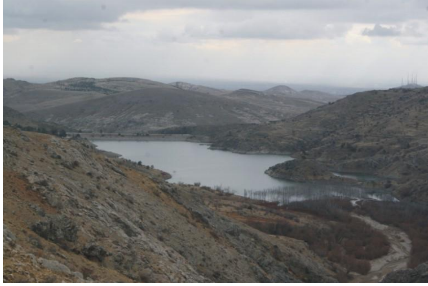
Şekil 8.2. Sille barajından bir görünüm
