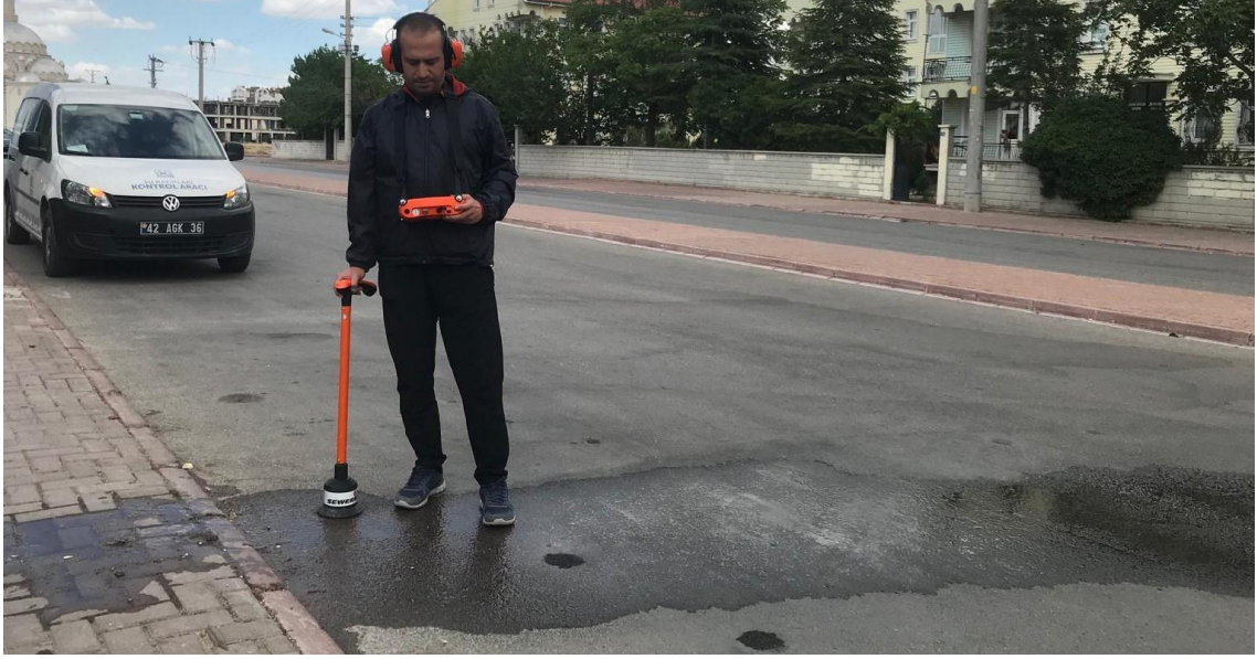
Şekil 5.23. Akustik dinleme mikrofonu ile arıza yeri tespiti
