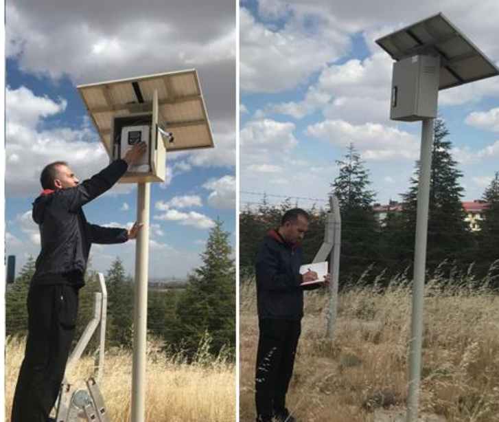
Şekil 5.8. Ultrasonik debimetre montajı
