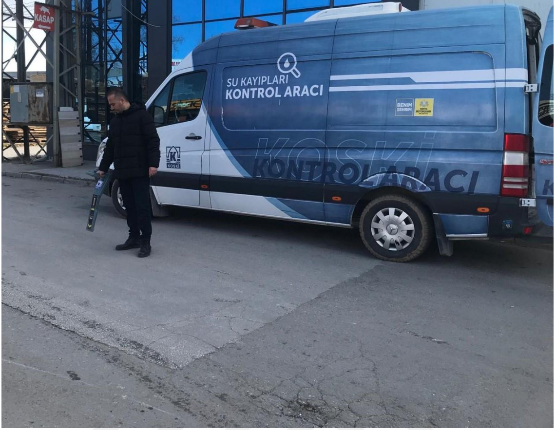
Şekil 5.17. Hat tespit cihazı ile tarama
