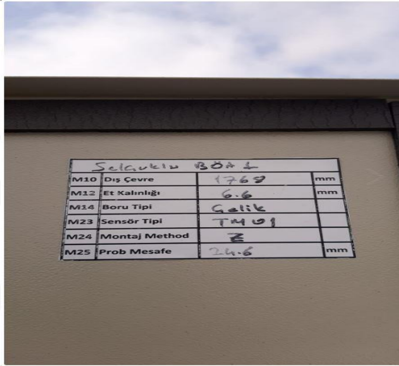
Şekil 5.9. Data toplayıcı montajı
