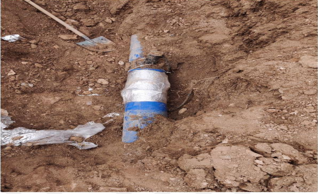
Şekil 5.7. Basınç sensörü montajı
