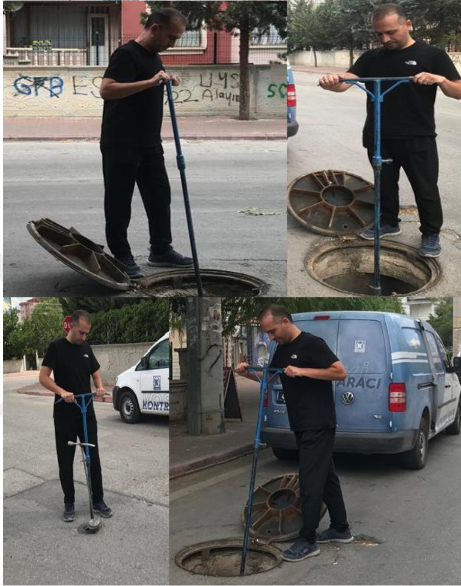
Şekil 5.5. Selçuklu DMA 01 vana kapatma işlemleri
