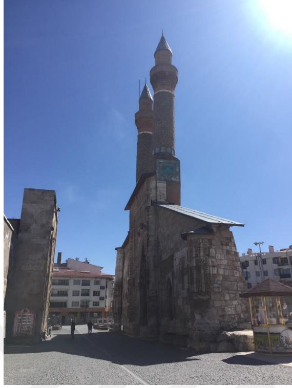
Ek 5 : Sivas Dârü's-sihhası'nın bulunduğu sokak.
