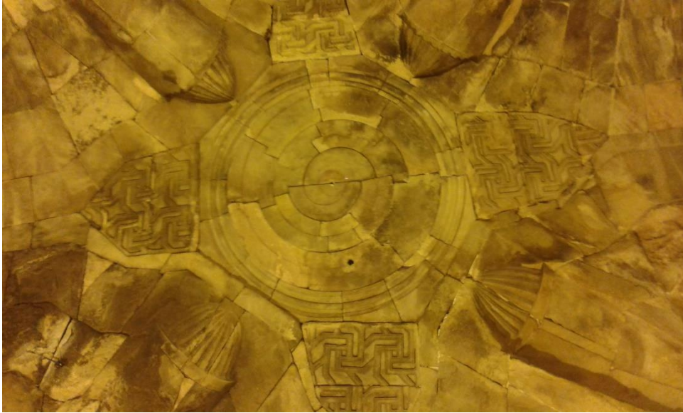
Ek 12 : Divriği Dârü's-şifâsı'nda bulunan havuzdan bir detay. Necdet Sakaoğlu bu kısmın yapıya sonradan eklendiğini, küçüklüğünde yapıda bu kısmın bulunmadığını ifade etmektedir. Dârü's-şifâ'da bulunan havuz 1960'lı yıllarda inşâ edilmiştir.
