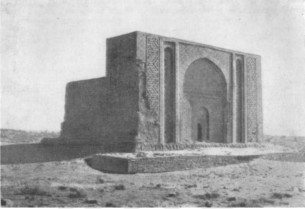
EK 9 Hüdanazar Evliya Türbesi Doğu Cephesi (Pugaçenkova, 1958:311).
