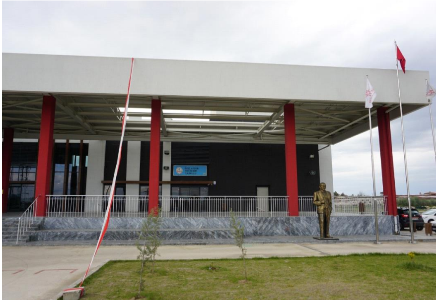
Şekil 5. Özel Mektebim Okulları Afyon Şubesi İlköğretim Okulu ve Lisesi, A Blok (Okul Öncesi Eğitim ve İlköğretim Birinci Kademesinin Giriş Kısmı), 9 Mayıs 2019
