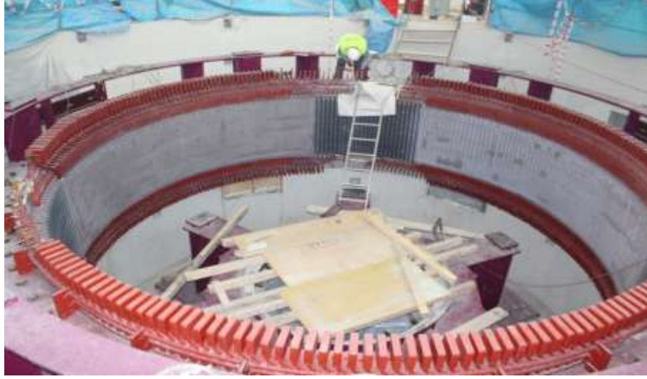
Şekil.12 Bağıtaş I HES senkron generatör stator sargıları
