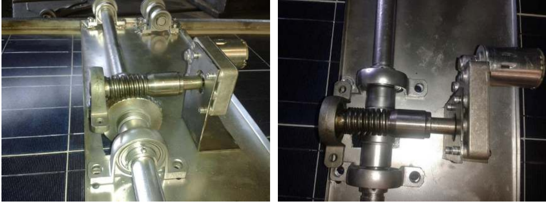
Şekil 3.10 Elektrik motoru montajı.
